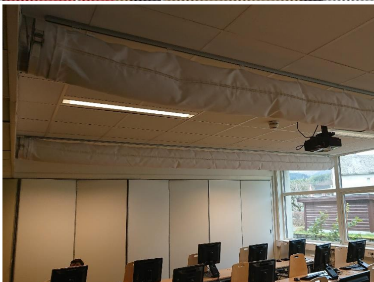
Bilde 330: Tekstilkkanalar for rehabiliterte fløy D. Desse er og brukt i fleire andre rom i fløy A.
