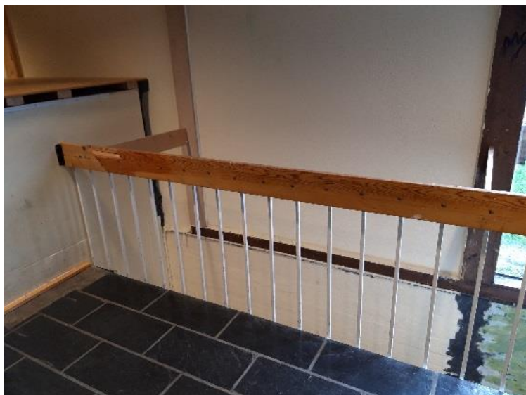
Bilde 230: Rekkverk ved trapp fløy A.
