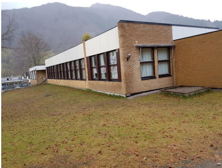
Bilde 207: Yttervegg Fløy E.
