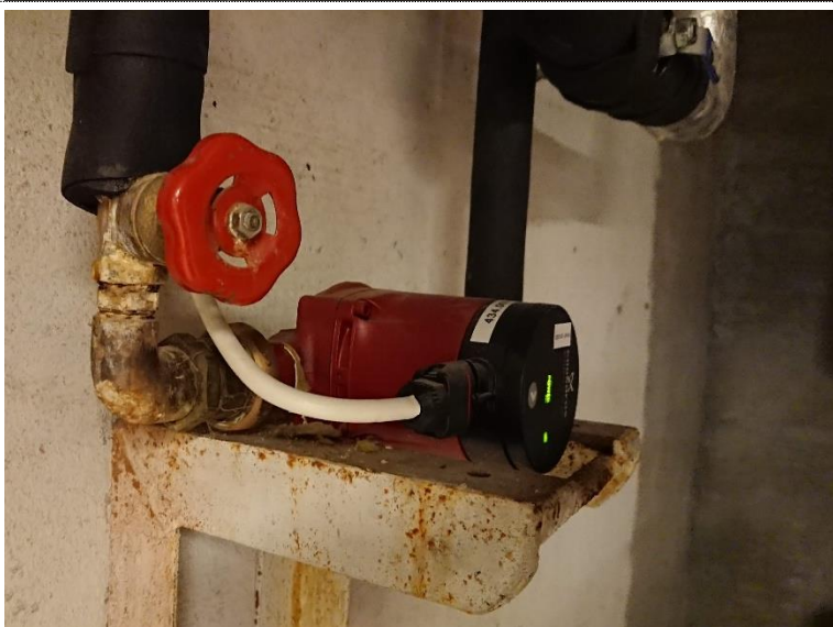
Bilde 306: Ny Grundfos sirkulasjonspumpe kopla til sirkulasjonsleidning frå byggeår – 1964.
