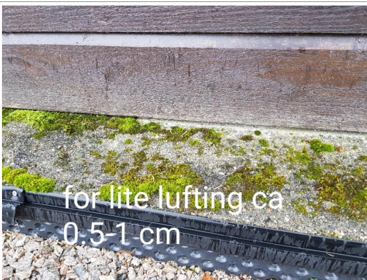
Bilde 209: Yttervegg i kjeller mot sentrum, for lite lufting.
