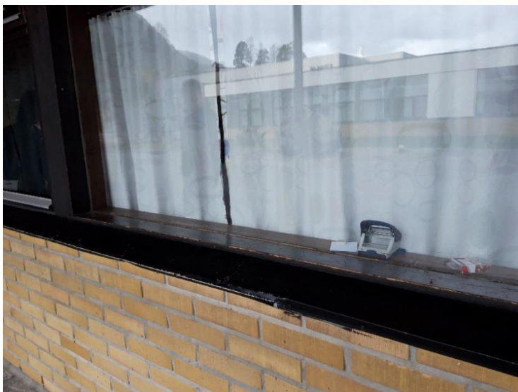
Bilde 211: Generell tilstand vindauger frå byggeår – 1967.
