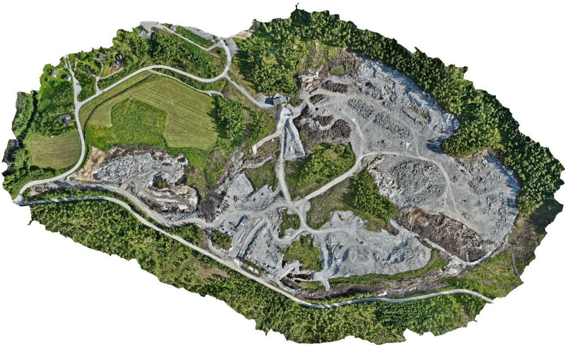
Figur 29: Ortofoto, det er påbegynt grunnarbeid i K4 (foto datert 13.06.2024)
