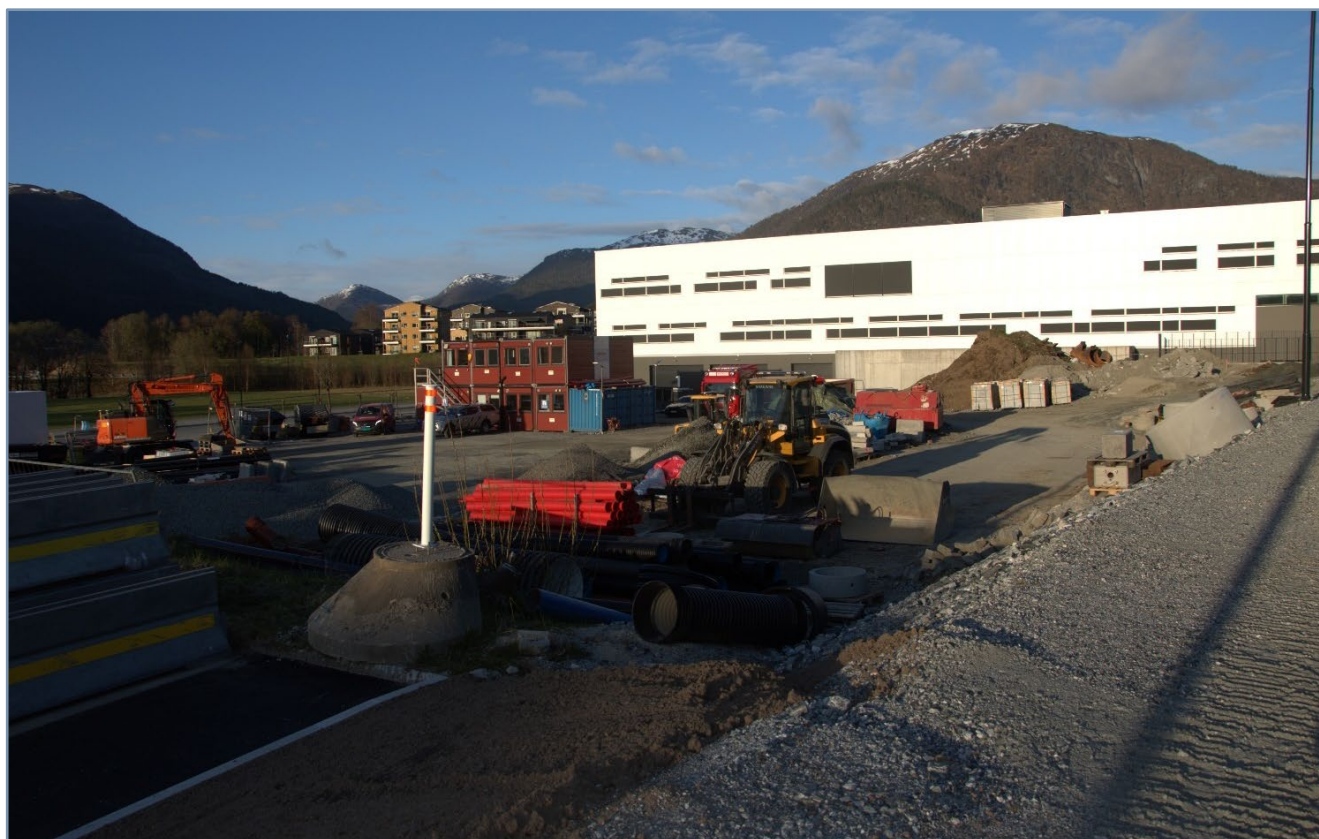
Figur 26: Dagens situasjon, område for ny brannstasjon vert nytta til riggplass i samband med vegarbeid (iVest Consult)
