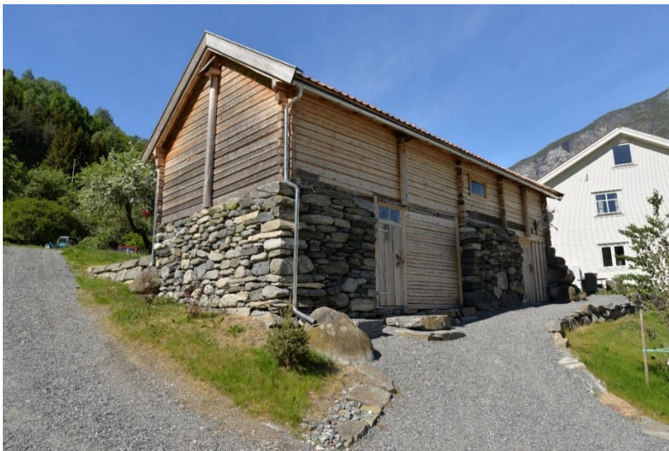
Figur 4. Etter istandsetting. Murane på Hansalåni vart sett opp att og det meste av konstruksjonen måtta laftast opp att. Foto S. Nordrumshaugen/VLFK.
