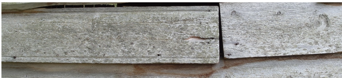
Figur 9. Dei høvla rennene på kvar kant av bordet syner ombruk av takord. Foto S. Nordrumshaugen/VLFK.
