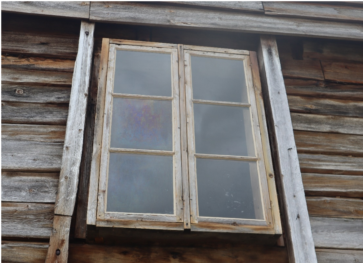
Figur 11. Nystelte vindauga. I mange tilfelle har ein ikkje måla vindauga tidelgare. Det vart gjerne ikkje prioritert på uthus. Foto Jorunn Vallestad/Statsforvaltaren, 2021.
