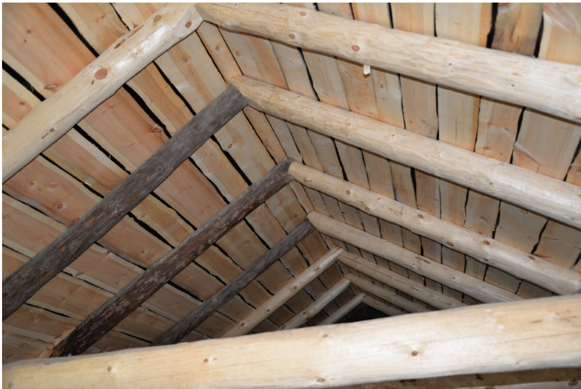
Figur 20. Takkonstruksjonen etter istandsetjinga. foto Stig Nordrumshaugen, 2019.
