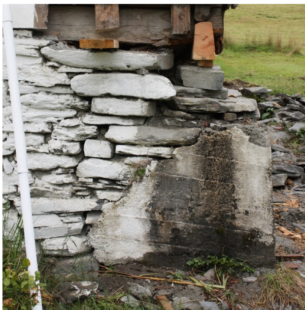
Figur 2. Grunnmur i stein som har blitt reparert med betong. Dette er ein ikkje-ønska metode for reparasjon. Foto S. Nordrumshaugen/VLFK.
