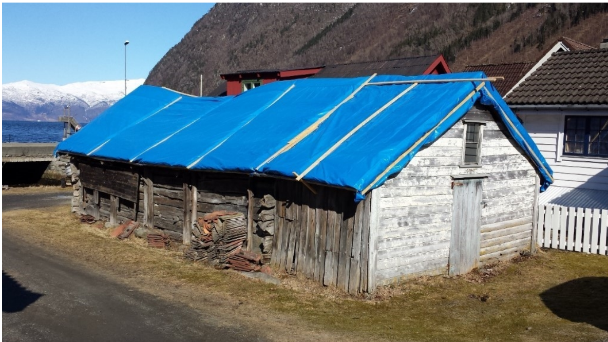
Figur 8. Mellombels sikring av naustet før istandsetjinga startar. Foto S. Nordrumshaugen/VLFK, 2018.
