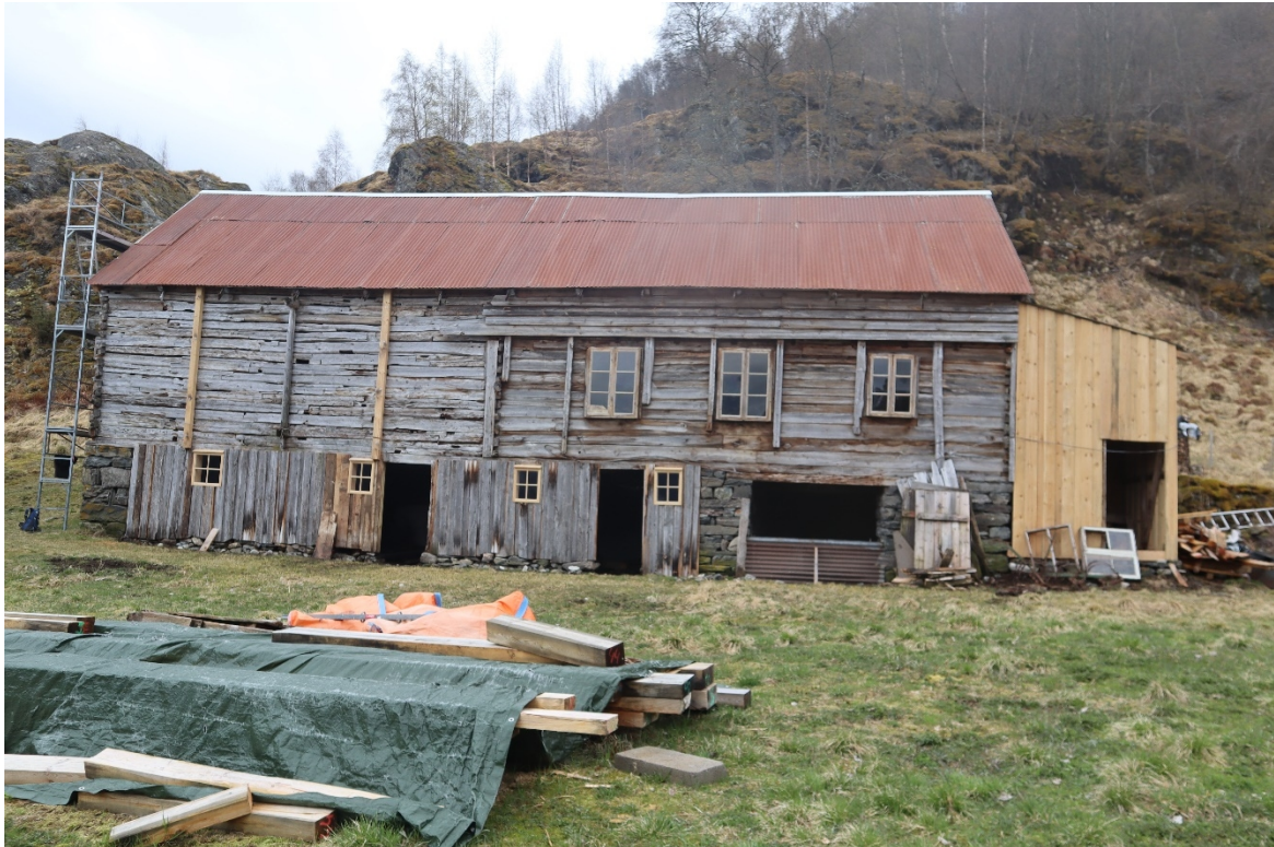
Figur 5. Løa på Øvste Stegen er eit godt døme på varsam istandsetting. Konstruksjon, mur og fundament, vindauge og kledning har vore sett i stand. Foto Jorunn Vallestad/Statsforvaltaren, 2021.
