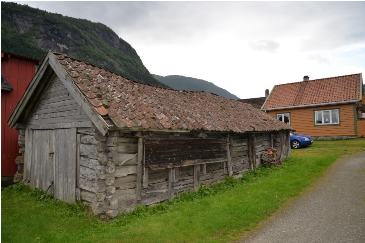
Figur 6. Naustet før istandsetjinga. Foto S. Nordrumshaugen/VLFK, 2017.
