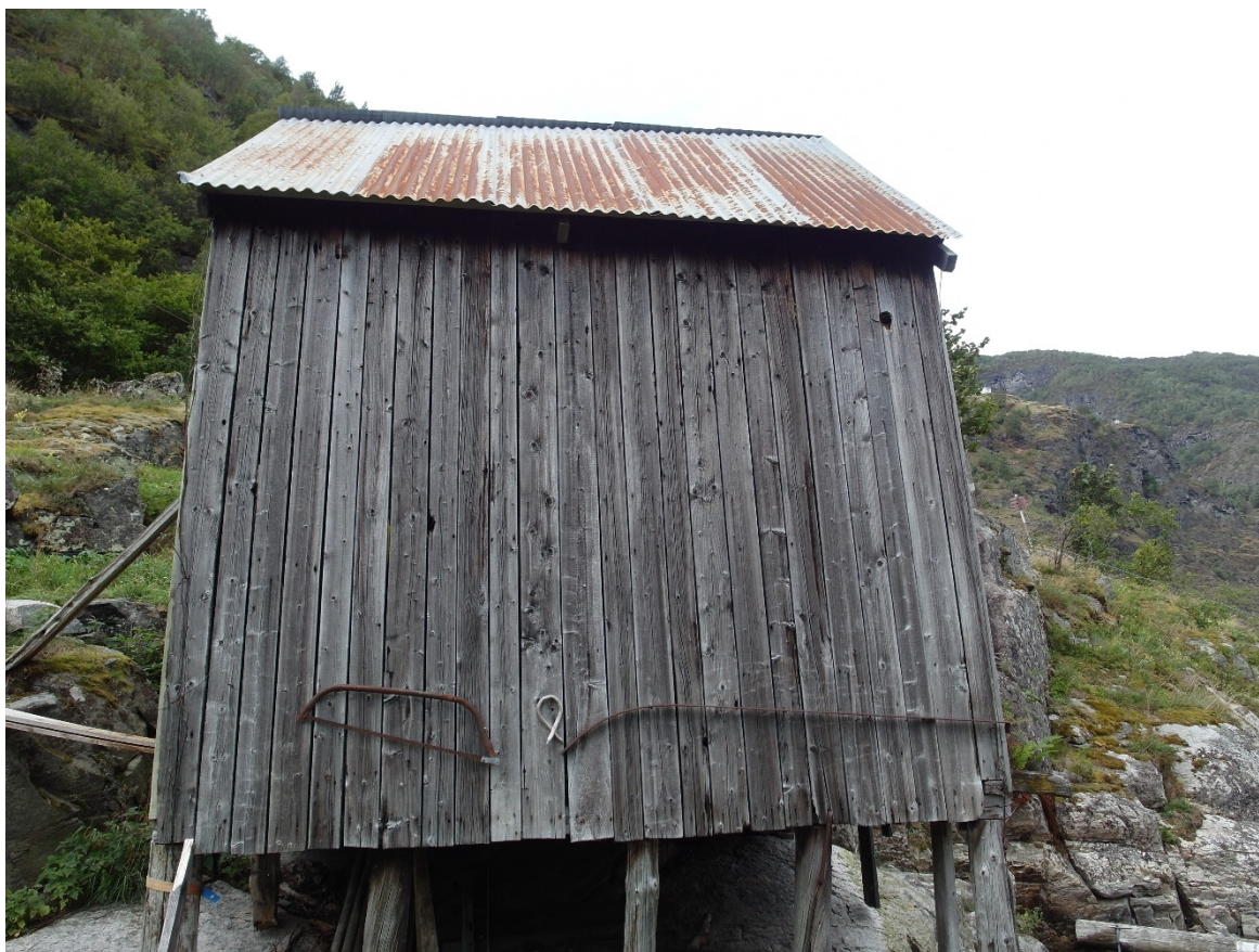
Figur 10. Utløe på Stokko. Døme på stande kledning kant i kant. Foto S. Nordrumshaugen/VLFK.
