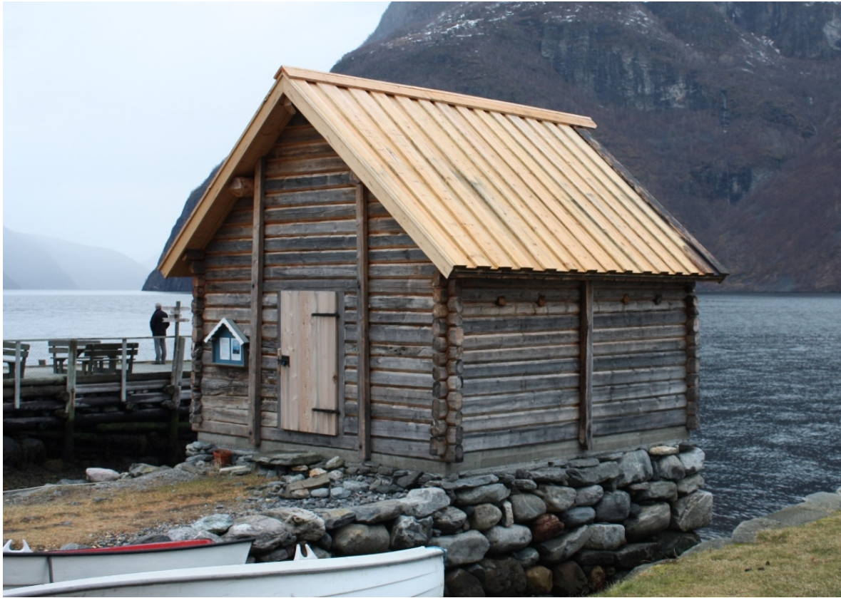
Fig. 6. Rekonstruert naust med bordtak i Undredal. Foto, Arlen Bidne VLFK, 2011.
