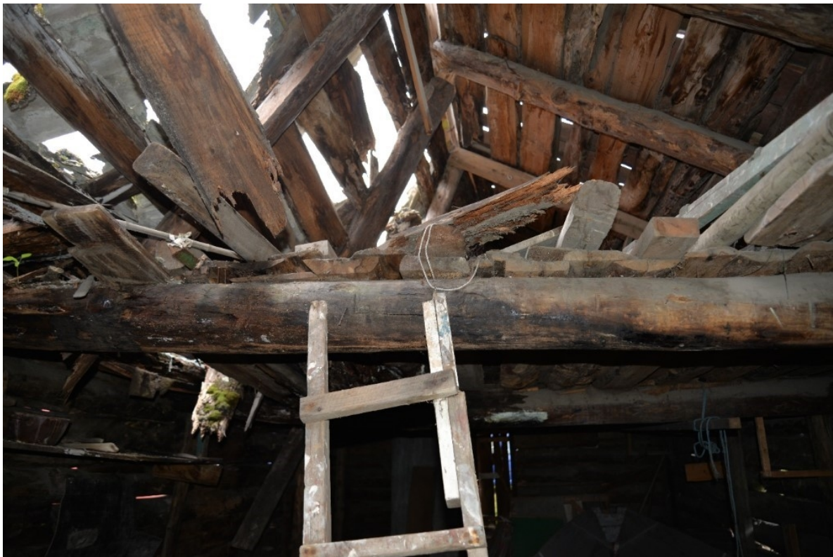
Figur 7. Foto S. Nordrumshaugen/VLFK, 2017.
