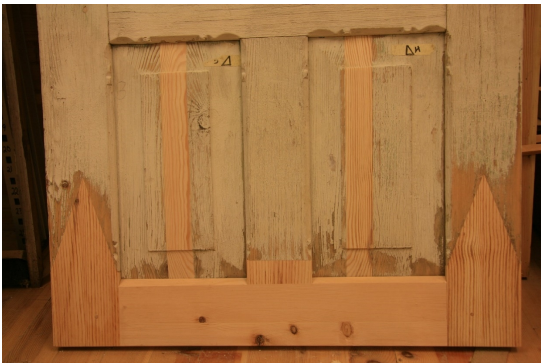
Figur 11. Dør på Øvste Stegen reparert av Knut Olav Lie. Foto Knut Olav Lie.
