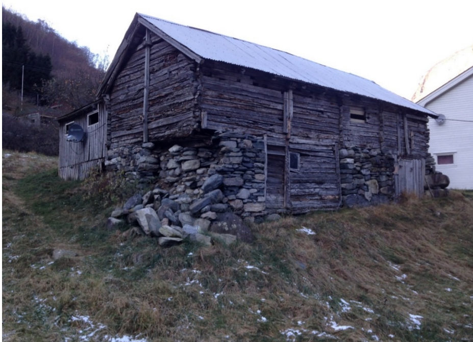
Figur 3. Før istandsetting. Hansalåni i Undredal vart eit svært omfattande prosjekt. Låni hadde store husbukkangrep og utrasa grunnmur. Foto S. Nordrumshaugen/VLFK.
