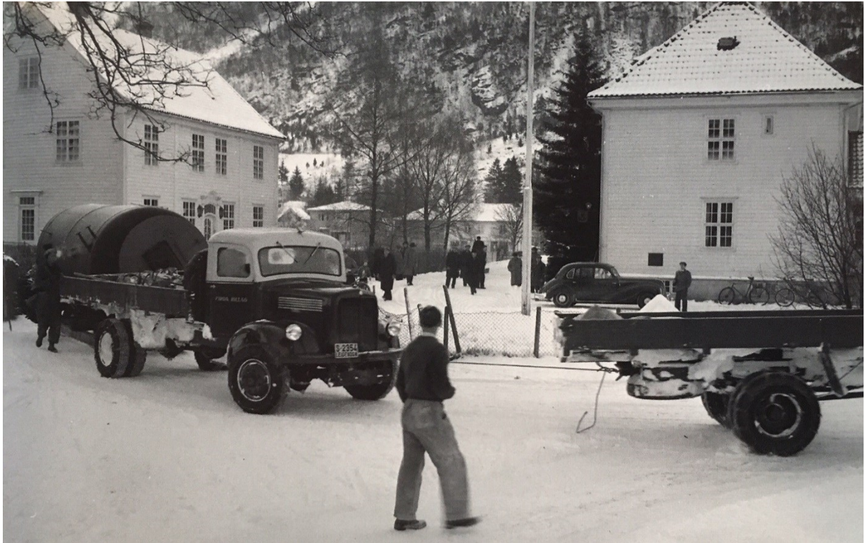
BILDE 12: «Lyskrysset» i 1953. Apoteket «Pontoppidan» t.v. og posten t.h. Førde Meieri flyttar frå Teigen til nytt bygg i Storehagen – her vert den store mjølketanken flytta. Foto: D. Reiakvam
