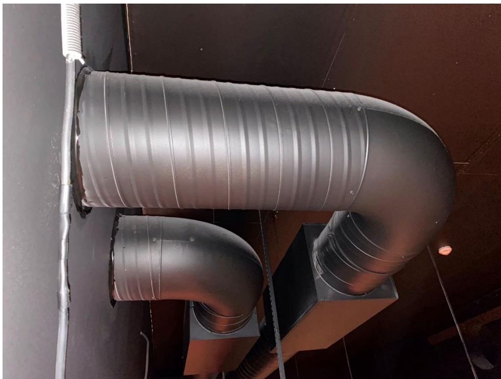
Figur 10. Ventilasjonsgjennomføringer over himling i Storsalen
