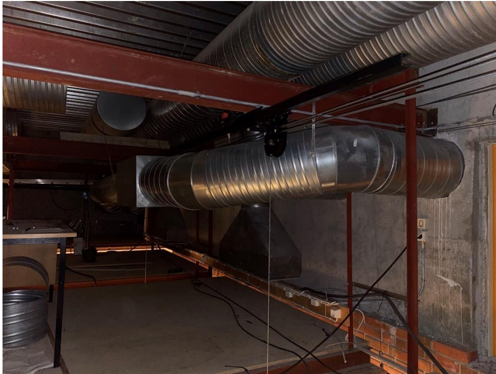
Figur 9. Ventilasjonsgjennomføringer over himling i Festsalen
