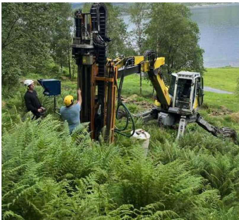
Figur 6: Vegetasjon med bregner, typisk for våte soner, der mothelling og et uorganisert dreneringsnett legger til rette for infiltrasjon
