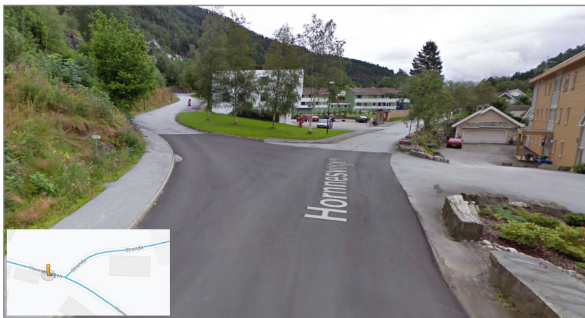
Figur 3-9: Gatebilde av krysset Stranda x Hornnesvegen. (Kilde: Google Maps)
