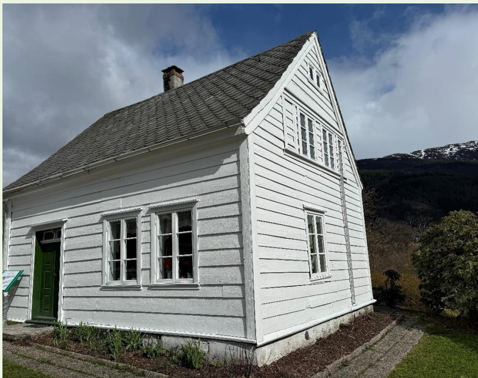
Nøysomhet/Ulltanghuset, eitt av dei eldste husa i Førde sentrum. Eigd av stiftinga Nøysomhet Førde (foto Anita Nordheim).
