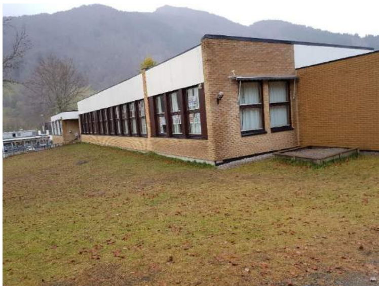
Bilde 207: Yttervegg Fløy E.
