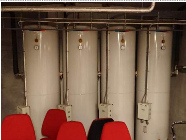
Bilde 315: 4stk. 390Lvarmtvassberedarar i energisentral.
