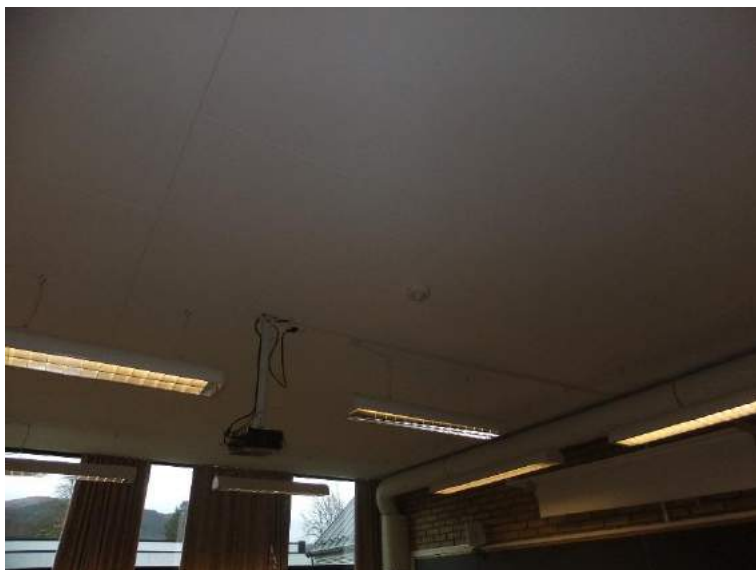
Bilde 418: Belysning i klasserom fløy C. Montert ca år 2001, styring med bevegelsesensor. Funksjon ok.
