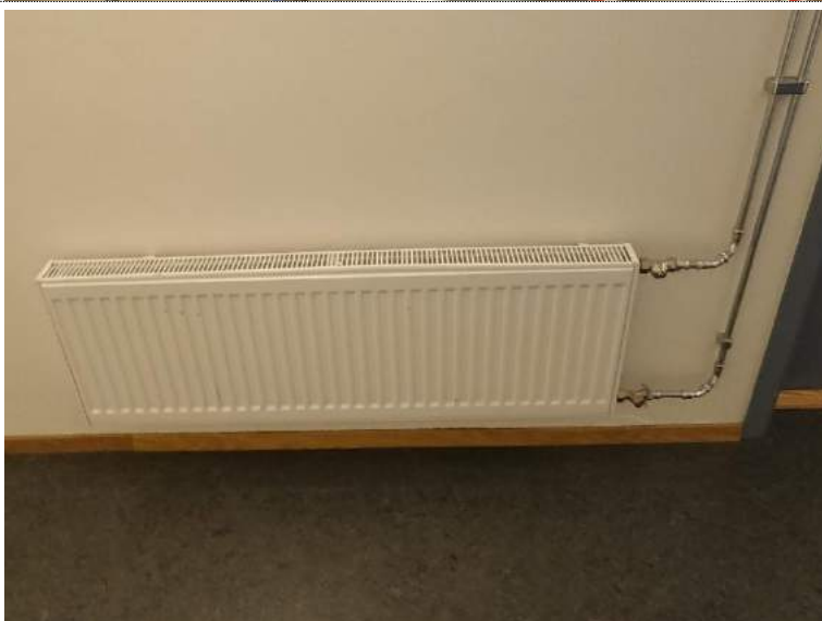
Bilde 324: Radiatorar i fløy D.
