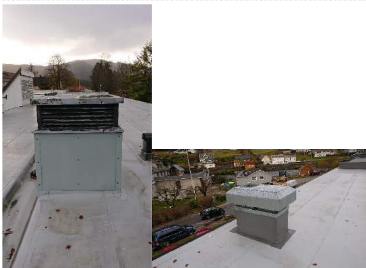
Bilde 228: Tak over fløy A.
