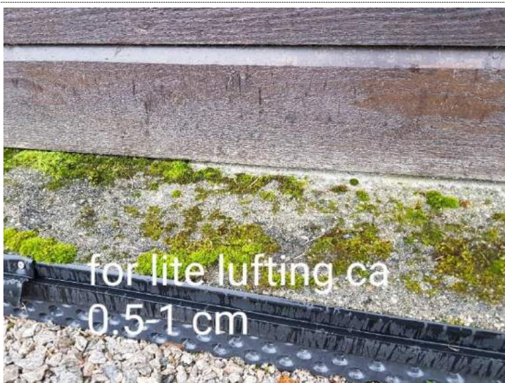
Bilde 209: Yttervegg i kjeller mot sentrum, for lite lufting.
