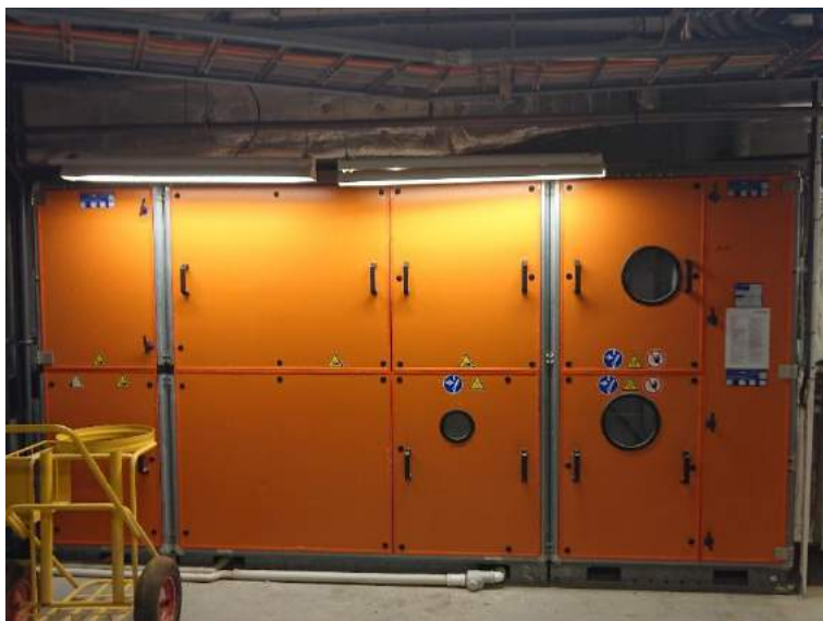
Bilde 337: Aggregat 36.11. Plassert i energisentral – Plan 0. Forsyner symjehall. Nytt i 2010.
