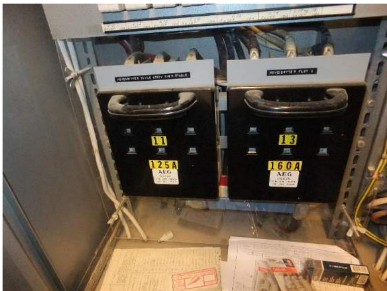
Bilde 403: Fordeling underetg. fløy A (ved metallforming). Original frå byggeår med NH-sikringar. Berøringssikkerheit ikkje etter dagens krav.
