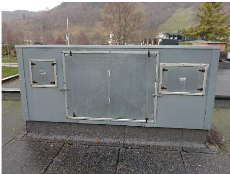
Bilde 334: Aggregat 36.05. Plassert på taket over fløy E. Forsyner delar av fløy E. Nytt i 1997.
