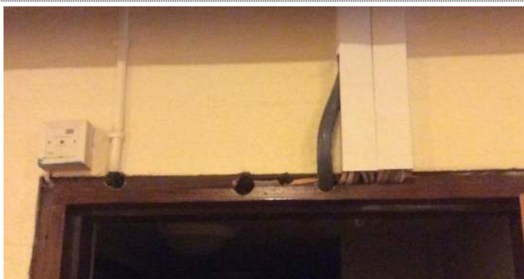
Bilde 218: Gjennomføringar i branncellebegrensande vegg som ikkje er tilfredsstillande branntetta. Bildet er tatt inn til el-travlerom i fløy A plan U.
