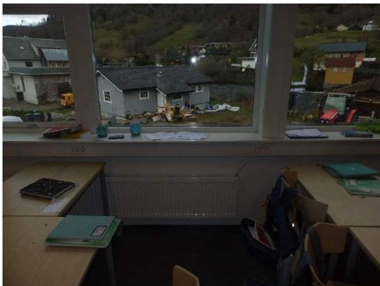
Bilde 415: Klasserom frå tilbygg i 2013. Kanal under vindauge med uttak. God og fleksibel løysing med utvidingsmogelegheiter. Vassbore varmeanlegg.
