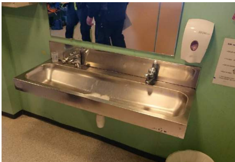
Bilde 301: Typisk vaskerenne i fløy E. Byggeår 1993.
