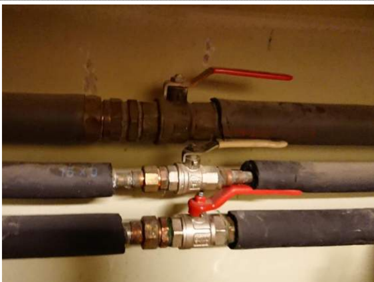
Bilde 317: Typisk isolering av vassleidningar i fløy A. Her er både kaldtvassleidning, varmtvassleidning og sirkulasjonsleidning isolert med cellegummi / kondensisolert.
