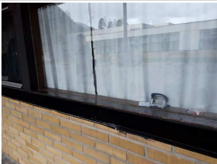
Bilde 211: Generell tilstand vindauger frå byggeår – 1967.
