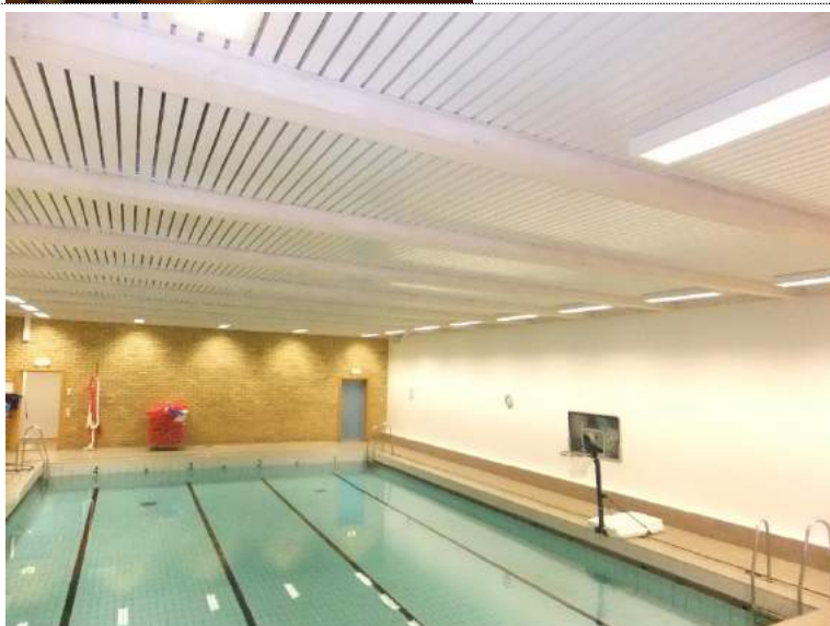
Bilde 417: Belysning symjehall. God stand, utskifta ved rehabilitering av tak i 2013.
