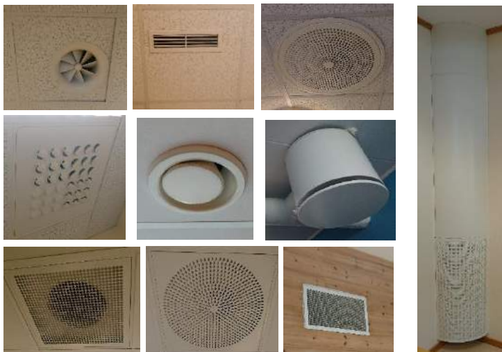
Bilde 328: Forskjellige tillufts- og avtrekksventilar på skulen.
