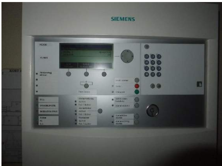
Bilde 424: Brannsentral ved inngang til fløy A (ende av bygg)
