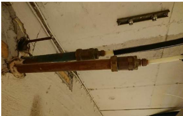
Bilde 307: Vassleidningar frå byggeår (1964) kopla til RIR PEX røyr av nyare dato.
