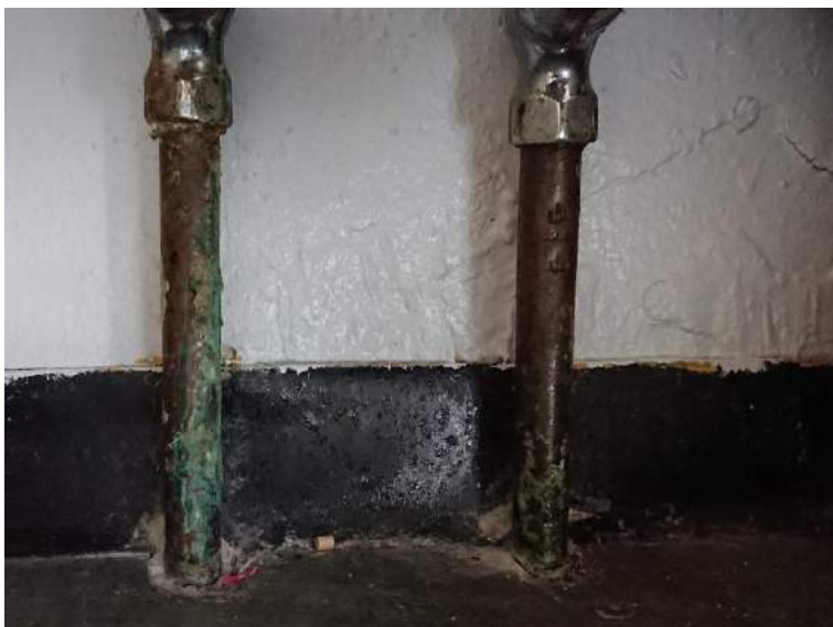
Bilde 305: Typiske røyrtilkoplingar til sanitærinstallasjonar i fløy A, B og C. Røyrrnett er frå byggeår 1964.
