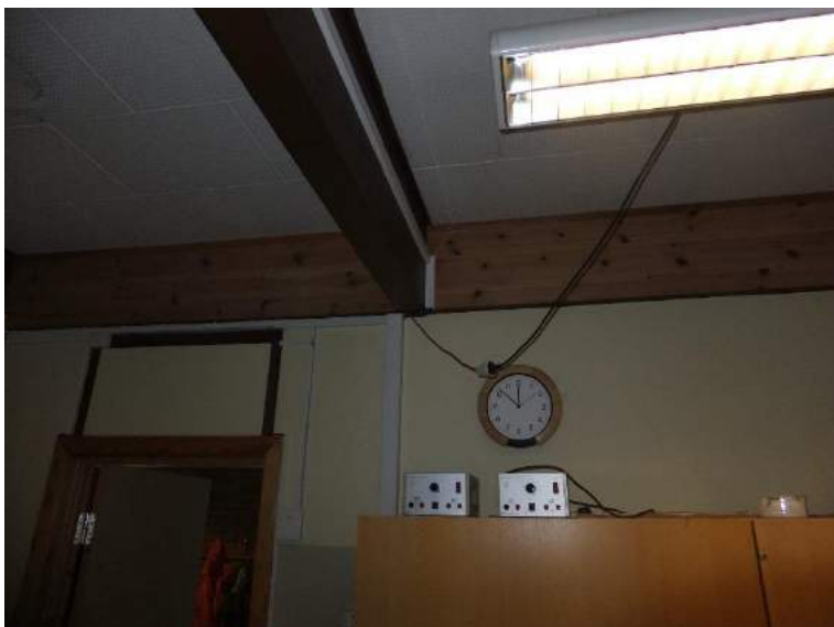
Bilde 413: Klasserom fløy A (naturfag). Skjøteledning nytta som fast opplegg, heng etter støpsel.
