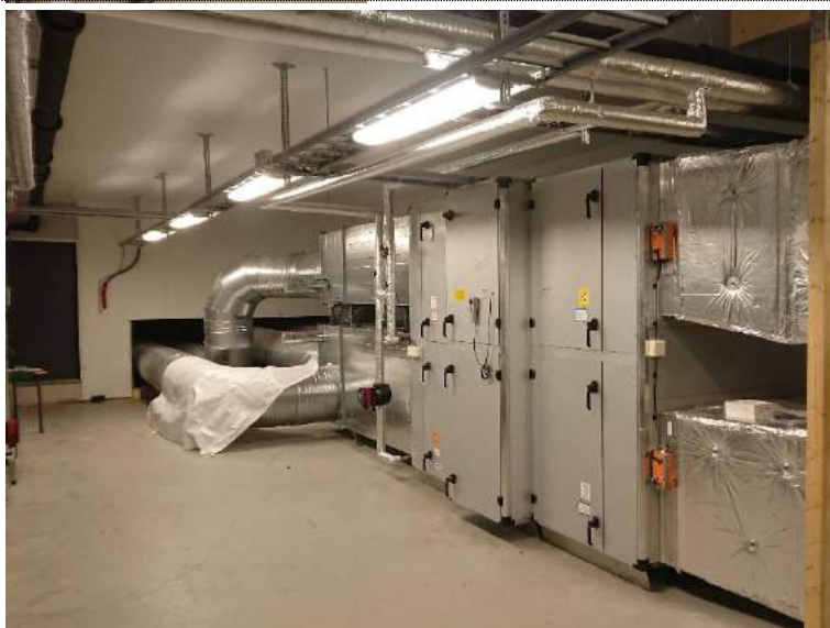
Bilde 332: Aggregat 36.03 og 36.12 (avbilda er aggregat 36.03). Plassert i plan 2 over kantine i fløy D. Forsyner fløy D og Gaularhallen. Nye i 2013.
