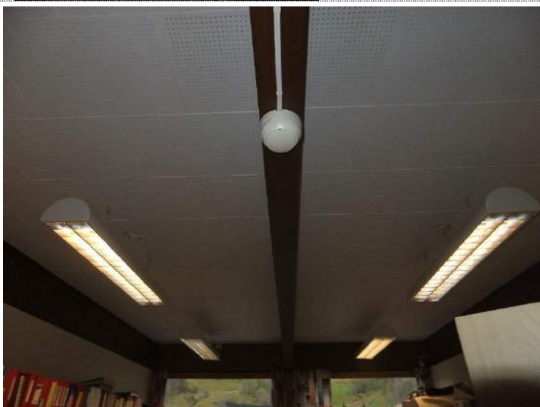
Bilde 423: Røykdetektor arbeidsrom fløy A.
