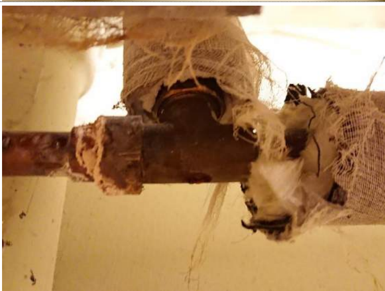
Bilde 318: Bilde av eldre isolasjon observert på lager for sløyd.
