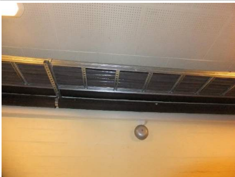
Bilde 410: Føringsveg for kablar i korridor underetg.
