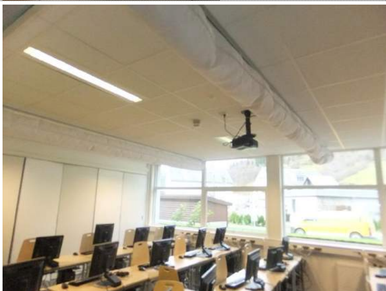
Bilde 429: Datarom fløy D. Ny installasjon i 2013. God tilstand.
