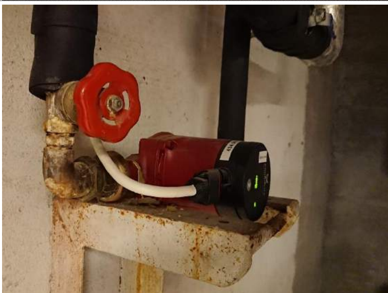
Bilde 306: Ny Grundfos sirkulasjonspumpe kopla til sirkulasjonsleidingning frå byggeår – 1964.
