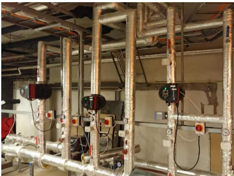
Bilde 323: Leidningsnett, pumper, ventilar og andre komponentar i varmeanlegg i energisentral.
