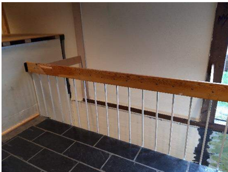
Bilde 230: Rekkverk ved trapp fløy A.
