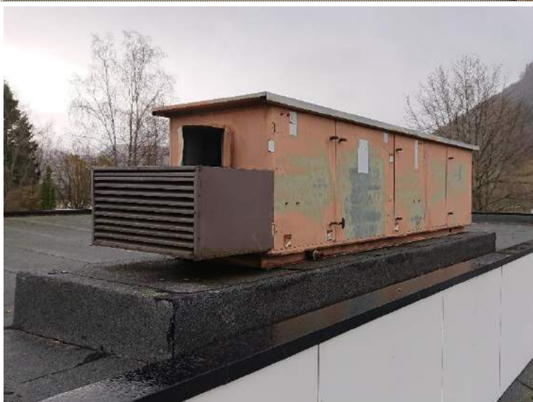
Bilde 333: Aggregat 36.04. Plassert på taket over fløy E. Forsyner delar av fløy E. Nytt i 1993.
