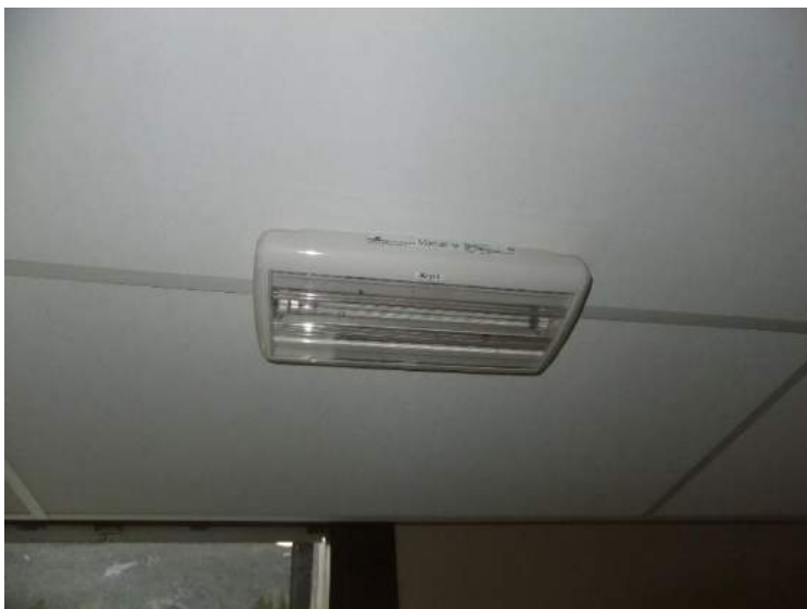
Bilde 433: Ledelys i korridor fløy A. Adresserbar type.
