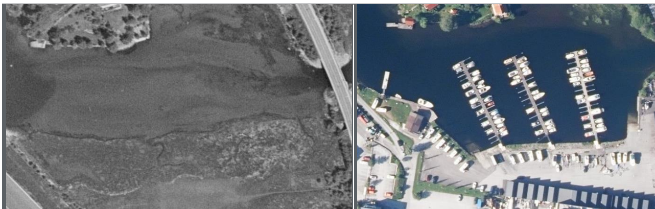
Figur 1.3: Ortofotoet til venstre er frå 1978 og syner situasjonen før småbåthamna vart etablert, medan bildet til høgre syner dagens situasjon med småbåthamn, opplagsareal for fritidsbåtar, parkeringsplassar og oppstillingsplassar for bubilar.
