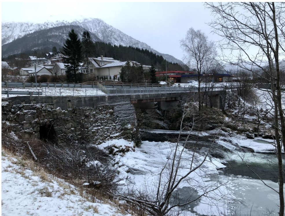
Figur 22 Gangbru ved Prestefoss sett fra nedstrøms side
