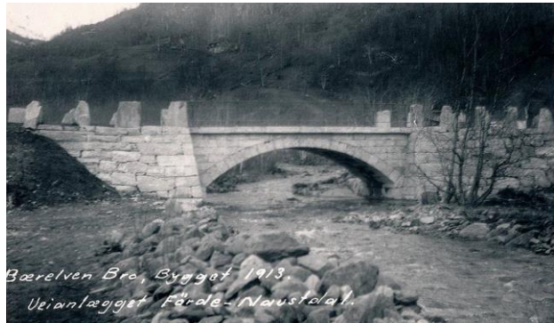
Figur 20. Bærelva bru. Foto: ukjent. Kulturminneplan for Naustdal
