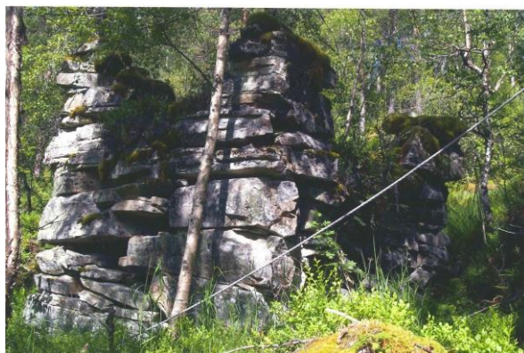
Figur 27. Ruin etter oppgangssaga i Styggelifossen. Foto: Privat. Kulturminneplan for Naustdal
