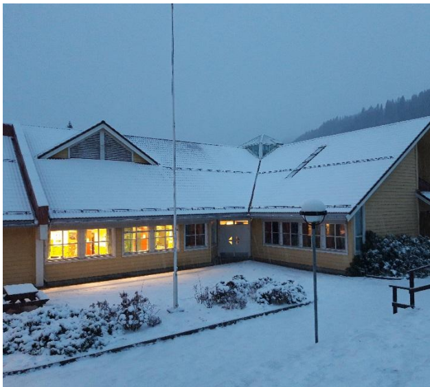
Bilde 200: Bygget generelt.
