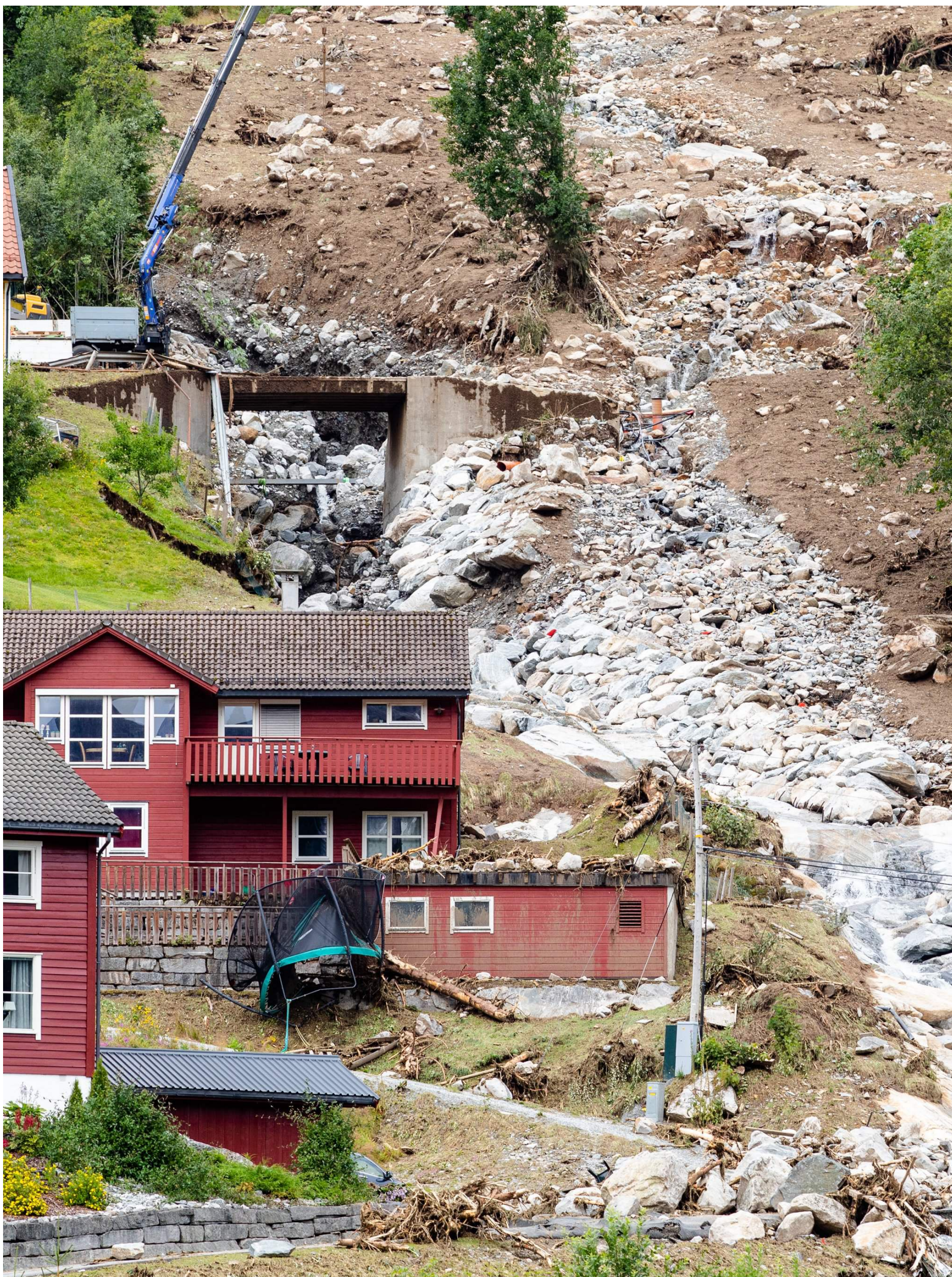
Store nedbørsmengder utløste 30. juli 2019 et jordras, som gikk mellom husene i et boligfelt på Vassenden i tidligere Jølster kommune, som nå er en del av Sunnfjord. En mann omkom da bilen hans ble tatt av raset.
