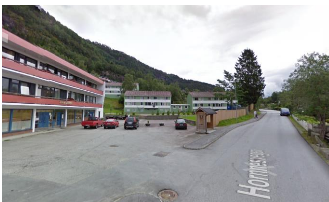
Figur 7: Bilete er teke frå krysset mellom Hornnesvegen og Stranda heilt vest i planområdet. Her ser ein korleis overflatevann frå vegen og parkeringsområdet vert samla opp i det konvensjonelle systemet for overvann ved hjelp av ein sandfangskum i vegen. Henta frå GoogleMaps.com.
