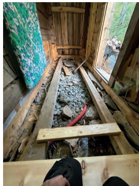
Sørøstre hjørnet ble hevet 25 cm (til høyre)
