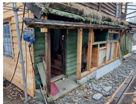
Svalgangen mot sør ble utbedret og nytt avkast fra ventilator ble plassert her.
