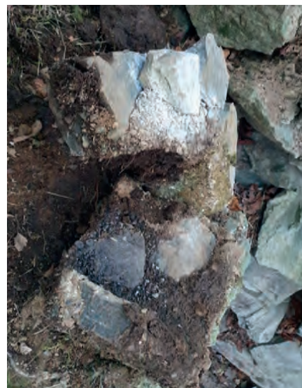
Rester av gammel pipe ble funnet i massene under bgygget. Denne viste at pipene var svært grovt murt og dannet utgangspunkt for ny oppmuring.
