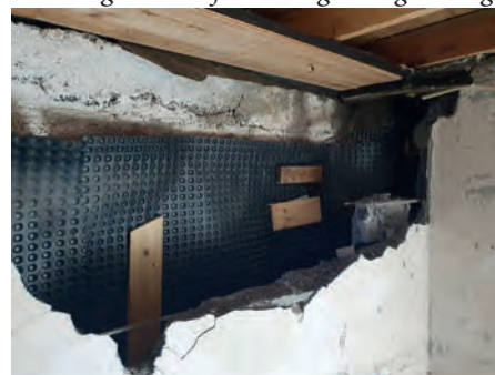
Tidligere utførte fuktsikringstiltak mot sør.
