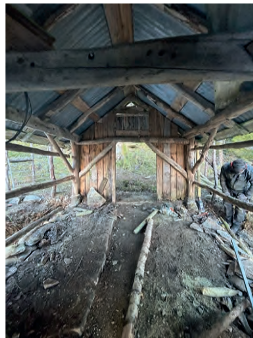
Gardsfjøset bar preg av fuktskader spesielt mot sør, der terrenget lå tett på trekonstruksjonene. Det støpte gulvet med renne ble beholdt som spor etter tidligere driftsform.
