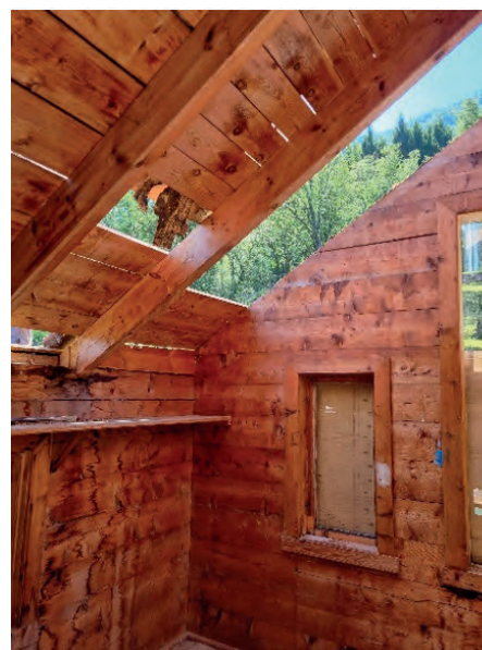
Rekonstruksjon av det overlyset i atelieret baserte seg på gode spor i bygget og på fotodokumentasjon.
