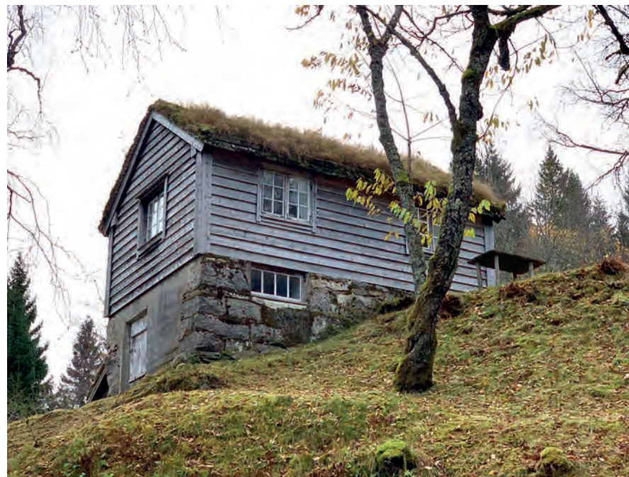
Før restaureringen. Gavlveggen mot nord var etterisolert og kledd med bord i gran.
