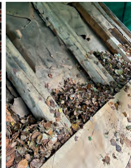
Løv som isolasjon i vegger og tak.
