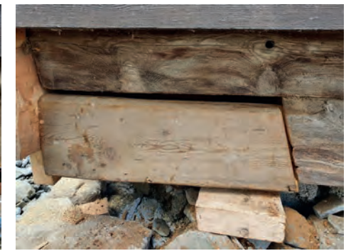
Utbedring av fundamenter mot sørøst, forsterket bjelkelag, drenering og utbedring av råteskader.
