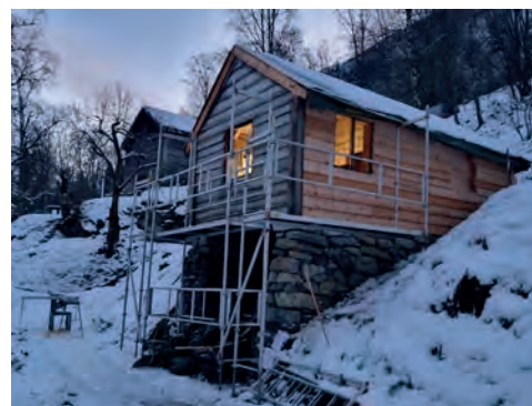
Bestastova heist på plass med ny reisverksdel mot sør.
