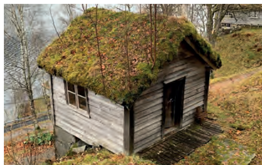
Her på baksiden stod det frem til raset på 1940-tallet en bygningskropp i reisverk. Døren på bildet har blitt brukt som ytterdør siden da, men er opprinnelig døråpningen mellom reisverksdelen og laftedelen i Bestastova.
