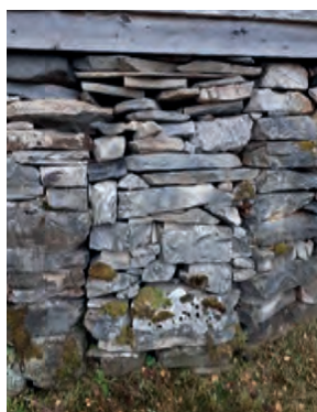
Spor etter tidligere åpning i grunnmuren mot nord.
