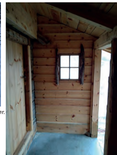
Det nye bislaget ble oppført i bindingsverk på ny støpt plate.
