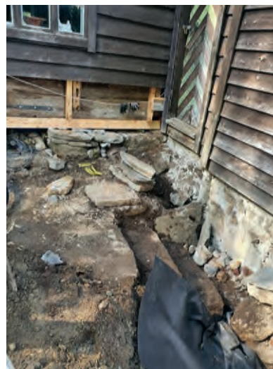
Tydelige spor etter inngang til potetkjelleren førte til at vi valgte å rekonstruere trappen ved siden av inngangen til Engels soverom.
