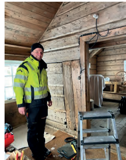
Det elektriske anlegget ble forbedret
