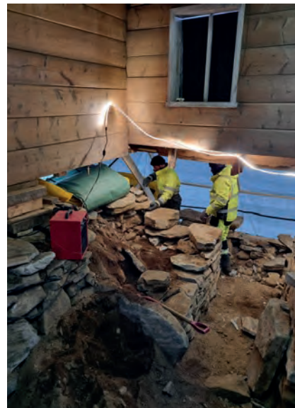
Store deler av muren måtte mures på ny.
