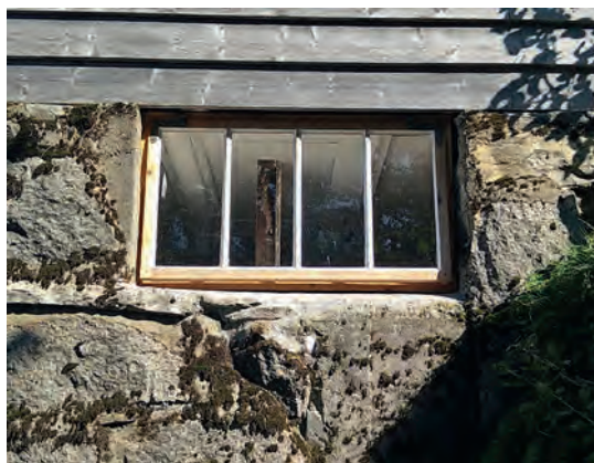
Vindusåpningen i kjelleren har endret format i nyere tid. Vinduet er nå tilbakeført til opprinnelig åpningsmål basert på sporene på stedet. Kjellerveggene er kalket innvendig som før.
