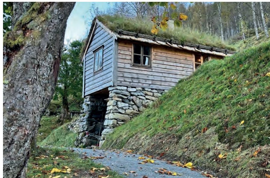
Bestastova komplett og ferdig restaurert.
