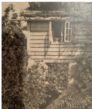
Vindusåpningen i kjelleren har endret format i nyere tid. Vinduet er nå tilbakeført til opprinnelig åpningsmål basert på sporene på stedet. Kjellerveggene er kalket innvendig som før.
