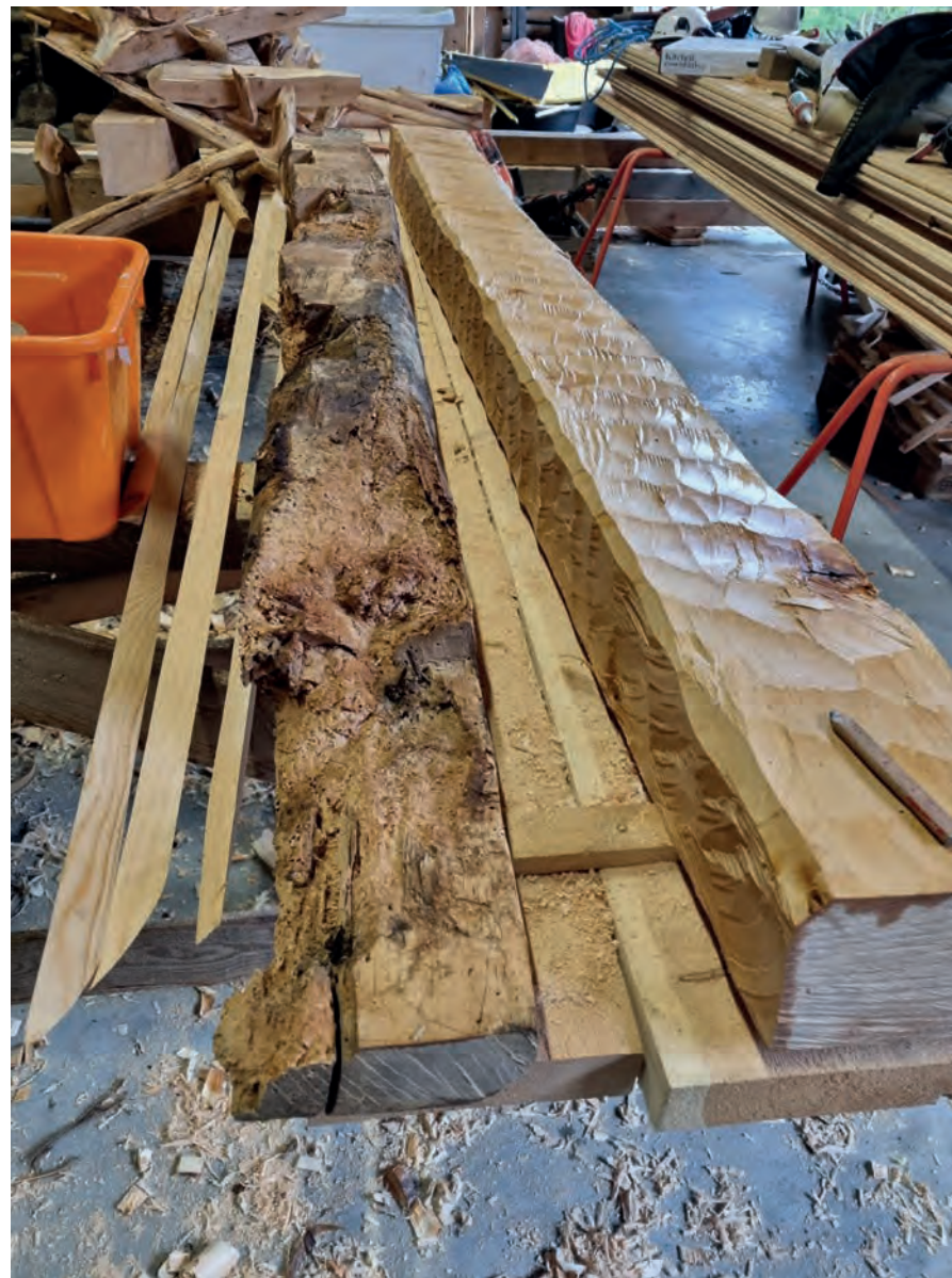
Alle bygningsdeler som har blitt skiftet ut har blitt erstattet med samme materialkvalitet og håndverksmessig utførelse som opprinnelig.
