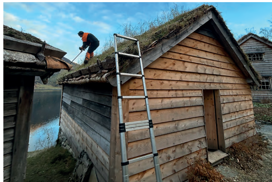
Sørøstre hjørnet ble hevet 25 cm (til høyre)
