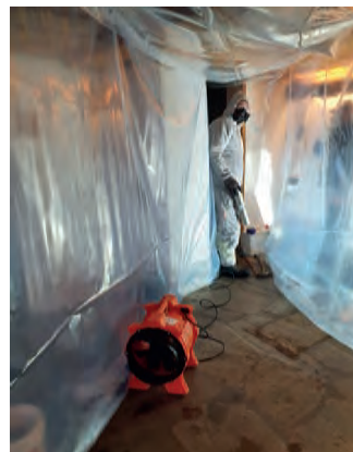
Saneringen ble utført med grundighet. Ingen alvorlige sopppforekomster ble avdekket.
