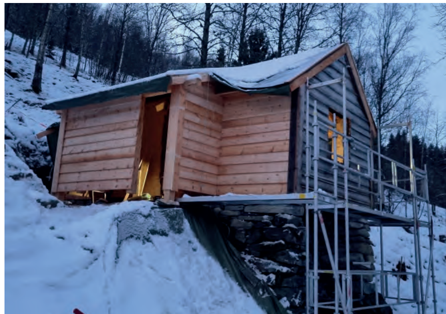
Ytterkledning på nordvegg er original og ble bevart. Ny kledning ble festet med klypt spiker.
