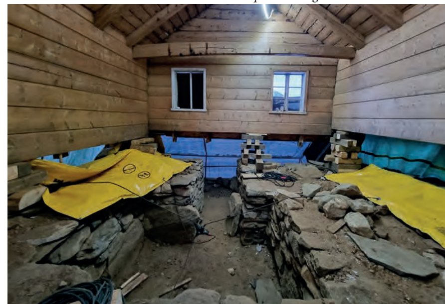
Tilbakeføring av kjeller med forgang
