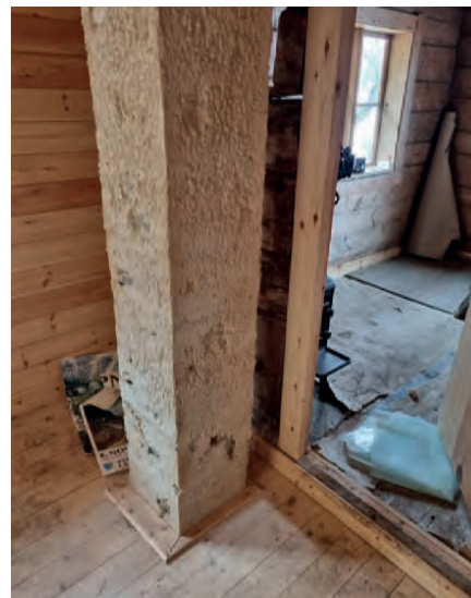
Det ble oppført ny pipe på de gamle pipefundamentet under bygget.
