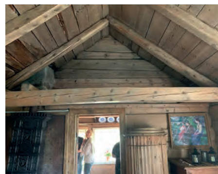
Det er spor av papp/ tapet på undersiden av taktroa i overgang til sperrene. Vi har ingen dokumentasjon på hva tid det var montert papp/ tapet her.
