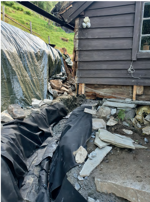
Utbedring drenering mot sør/ øst for å minske fuktgjennomtrengning i kjeller.
