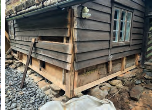
Utbedring av fundamenter mot sørøst, forsterket bjelkelag, drenering og utbedring av råteskader.
