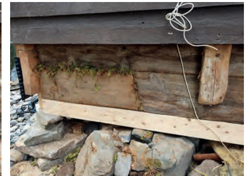
Alle utskiftninger er utført etter antikvariske prinsipper: skifte minst mulig og erstatte likt for likt.
