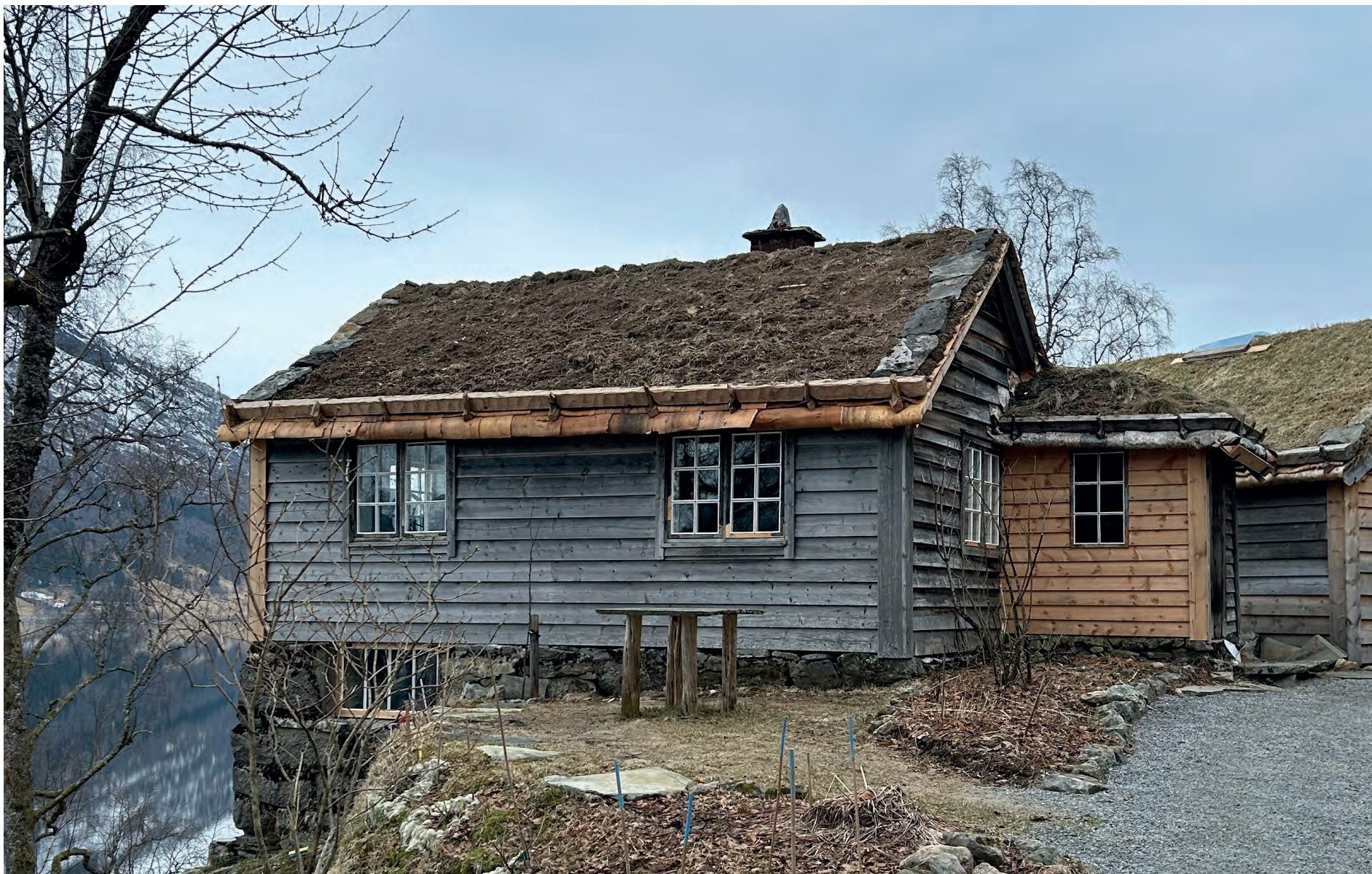
Kjøkkenstova ferdig restaurert
