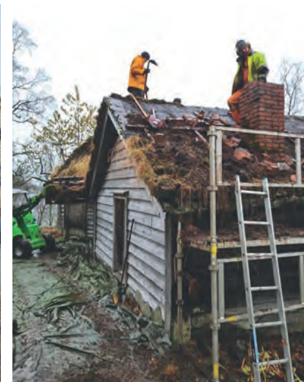
Taket ble lagt om. Pipen måtte demonteres for oppmuring av ny pipe
