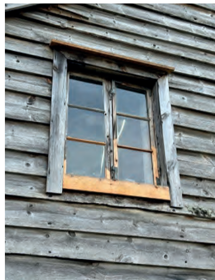
Vinduer ble restaurert etter antikvariske prinsipper. Ny dør utformet basert på tilsvarende dører i distriktet.
