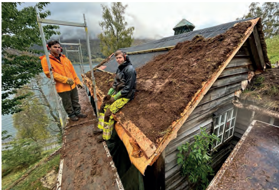
Jan Inge Dvergsdal og .... fra Slåtten Grind & Laft AS legger torvtak.
