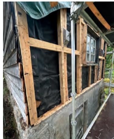
Nordveggen grankledning og isolasjon fra senere tid ble fjernet og erstattet med kledningsbord i furu.
