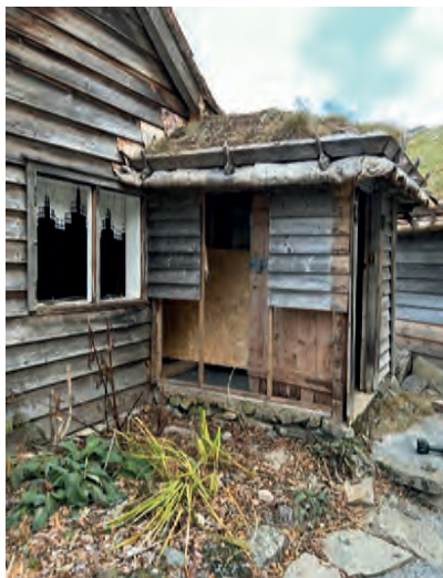
I vindfanget ble veggen mot vest fornyet. Her også her ble nyere grankonstruksjon skiftet ut og vi fikk rekonstruert veggen etter spor og funn.
