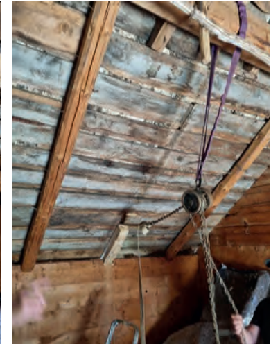
Ny sperr skal heise på plass.
