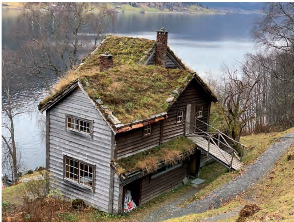
Borgen før og etter restaureringen.
