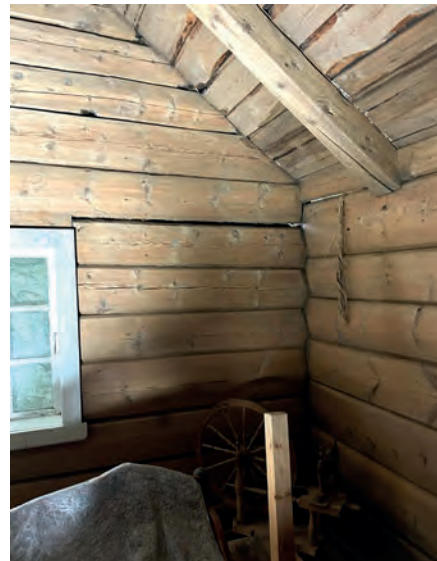
Sprekkdannelse i gavlvegg mot nord ble utbedret
