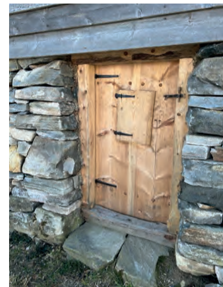
Vinduer ble restaurert etter antikvariske prinsipper. Ny dør utformet basert på tilsvarende dører i distriktet.
