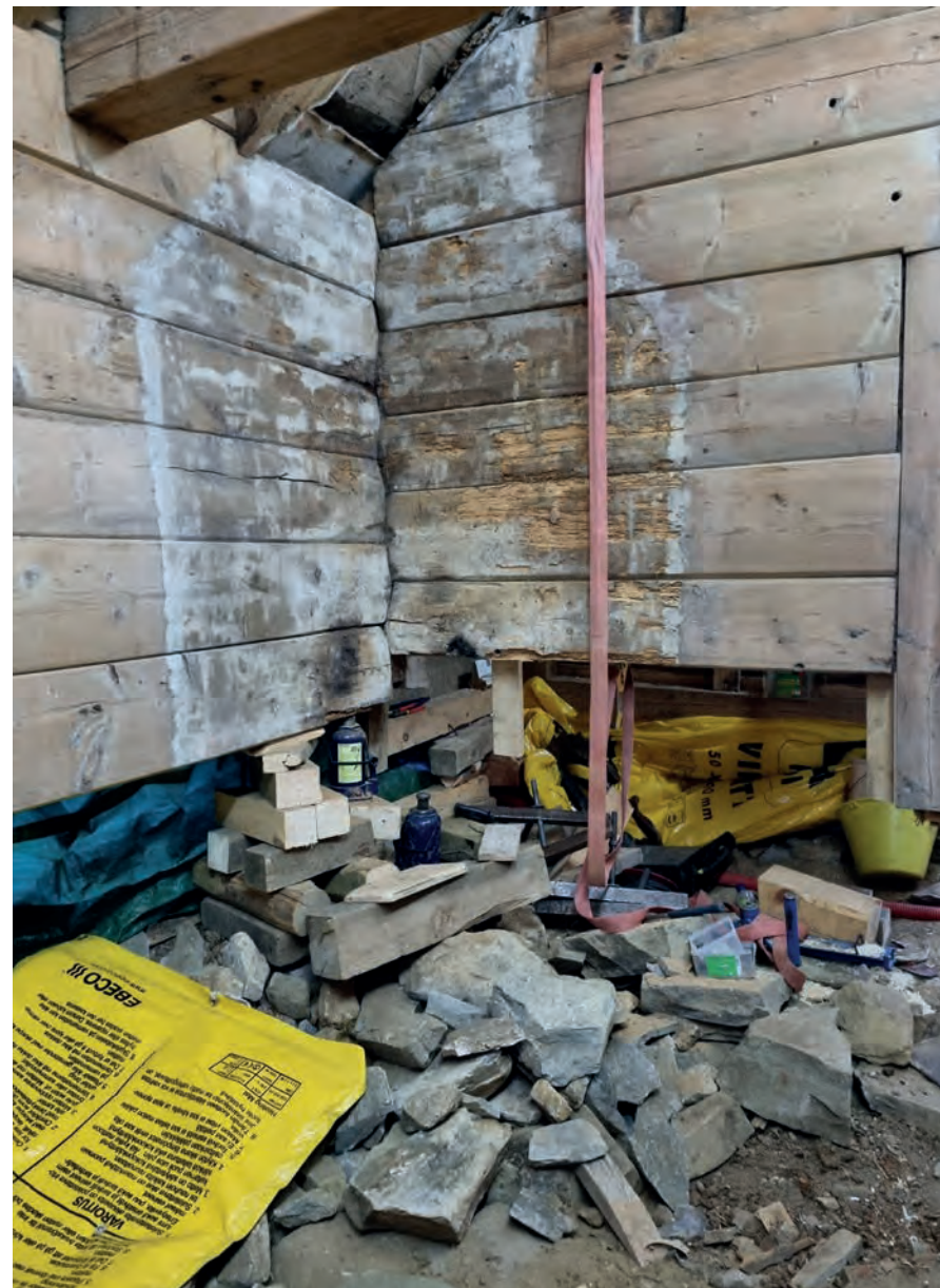
Pipe og peis måtte demonteres for å gjøre den nødvendige hevingen av bygget mot sørøst.
