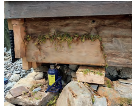
Alle utskiftninger er utført etter antikvariske prinsipper: skifte minst mulig og erstatte likt for likt.
