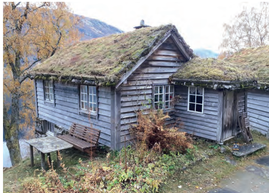
Fra tilstandsvurderingen utført i 2021
