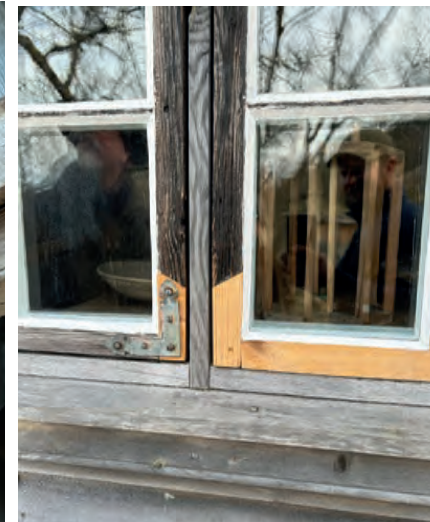
Samtlige vinduer ble tatt ut og restaurert etter antikvariske prinsipper.
