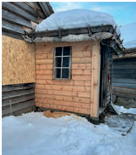
I vindfanget ble veggen mot vest fornyet. Her også her ble nyere grankonstruksjon skiftet ut og vi fikk rekonstruert veggen etter spor og funn.
