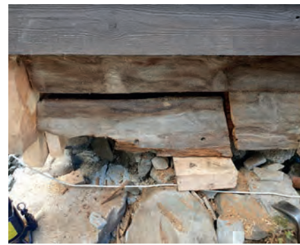
Utbedring av fundamenter mot sørøst, forsterket bjelkelag, drenering og utbedring av råteskader.
