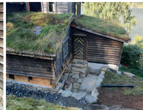
Tydelige spor etter inngang til potetkjelleren førte til at vi valgte å rekonstruere trappen ved siden av inngangen til Engels soverom.
