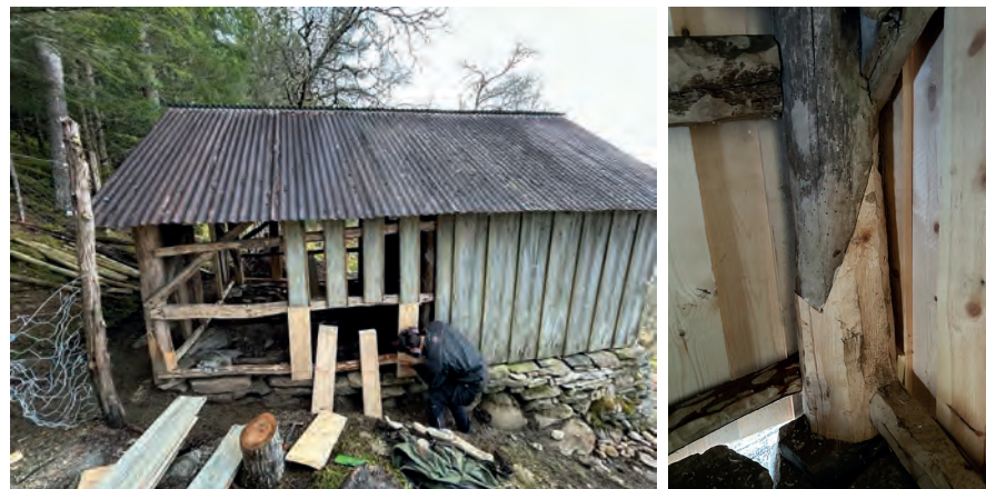
Fjøset ble restaurert etter antikvariske prinsipper. Kun det som var nødvendig å utbedre ble skiftet ut.
