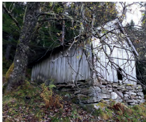
Gardsfjøset er bygget i grindverk.
