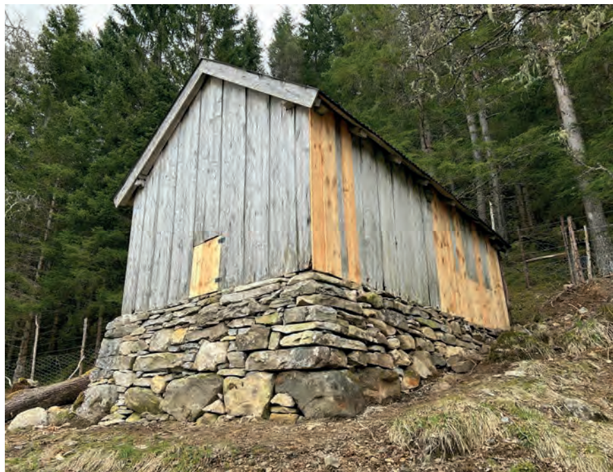
Terrenget ble bearbeidet rundt bygget, spesielt mot sør, for å unngå at bygget blir belastet med fukt.
