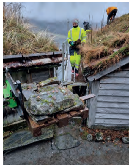
Demontering av kantskifer.
