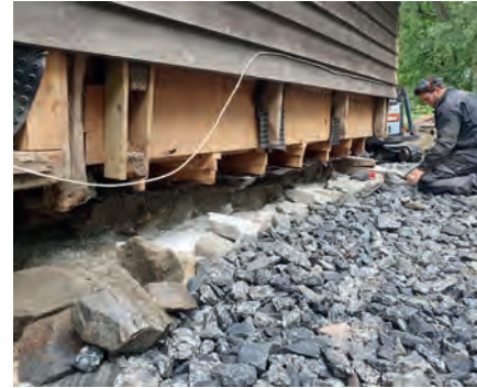
Utbedring av fundamenter mot sørøst, forsterket bjelkelag, drenering og utbedring av råteskader.
