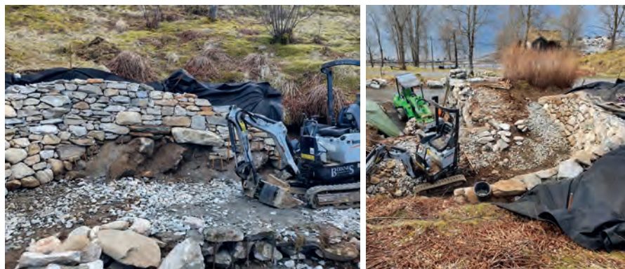
Det ble heist ned gravemaski og etterhvert etablert en kistesatt veite for å lede vekk alt vannet bak Bestastova. Hele murfundamentet ble hevet to omfar, ca. 20cm.
