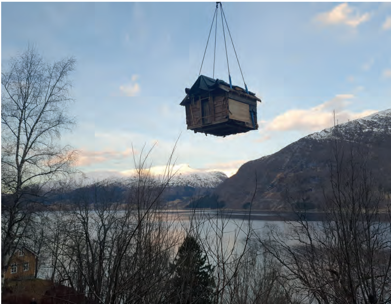
For å kunne jobbe effektivt både med murene og restaurering av selve bygget ble Bestastova heist av murene og plassert på parkeringsplassen ved Galleriet.
