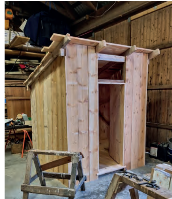
Utedoen ble bygget på verksted og heist på plass.
