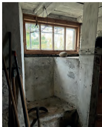
Vindusåpningen i kjelleren har endret format i nyere tid. Vinduet er nå tilbakeført til opprinnelig åpningsmål basert på sporene på stedet. Kjellerveggene er kalket innvendig som før.
