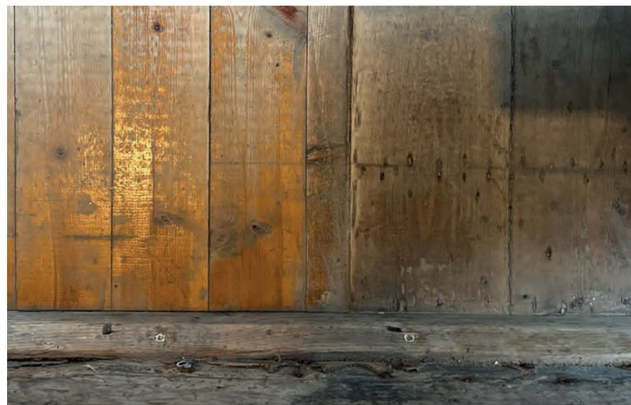
Ulike generasjoner gulv blir liggende i kjøkkenet.
