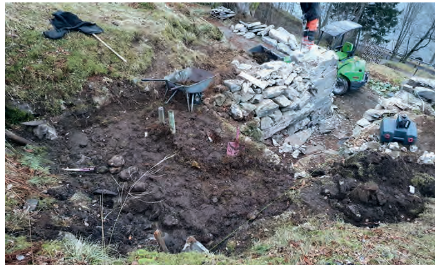
Den fremste delen av muren (mot nord) var støpt. Dette er sannsynligvis et sikringstiltak etter raset. I vangene var det brukt en del sprengt stein etter utsprenging av tomten.
