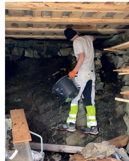
Det ble oppført ny pipe på de gamle pipefundamentet under bygget.
