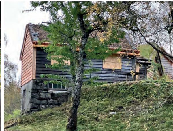
Nordveggen grankledning og isolasjon fra senere tid ble fjernet og erstattet med kledningsbord i furu.
