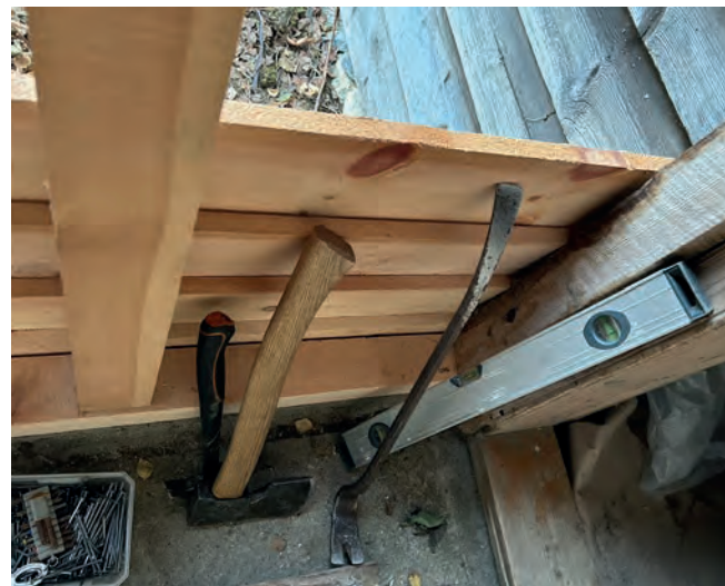
I vindfanget ble veggen mot vest fornyet. Her også her ble nyere grankonstruksjon skiftet ut og vi fikk rekonstruert veggen etter spor og funn.
