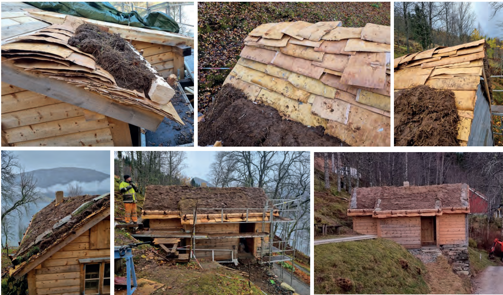
Takkonstruksjonen på Bestastova var ganske intakt. Trobordene er hovedsaklig gjenbrukte gulvbord. Etter noe utskifting ble det lagt nytt, tradisjonelt nevertak med 8 lag never. På bislaget ble det lagt knotteplast pga. den flate takvinkelen.
