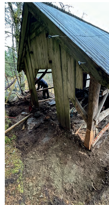
Gardsfjøset bar preg av fuktskader spesielt mot sør, der terrenget lå tett på trekonstruksjonene. Det støpte gulvet med renne ble beholdt som spor etter tidligere driftsform.
