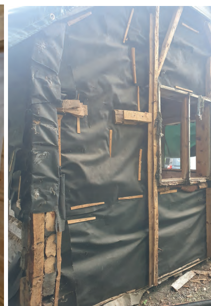
Restaureringen og bygging av bindingsverksdelen ble utført når bygget stod ved Galleriet.
