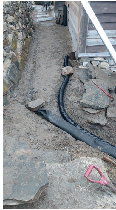
Utbedring drenering mot sør/ øst for å minske fuktgjennomtrengning i kjeller.
