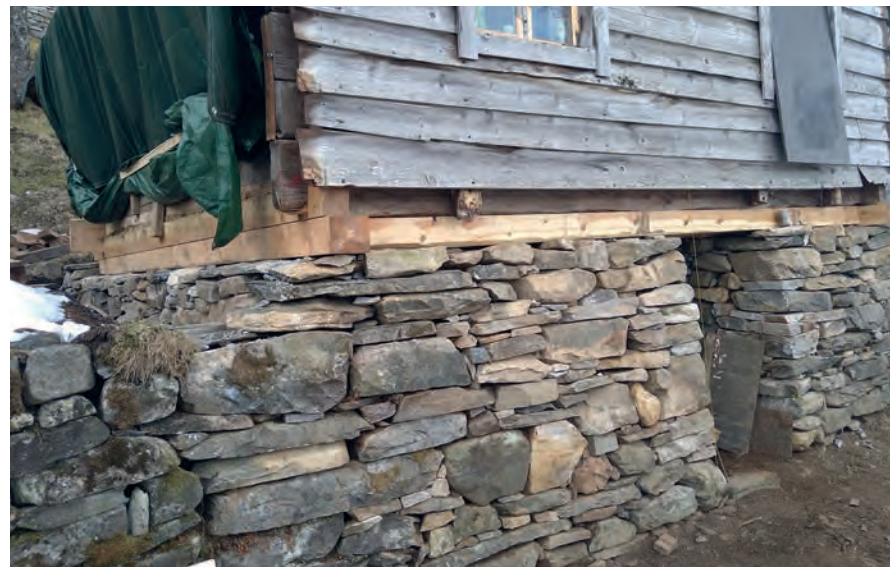
Nyoppmurt grunnmur og nytt opplegg for bjelkelag
