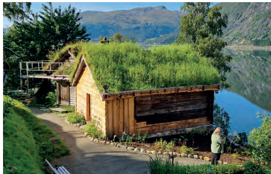
Gamlestova ferdig restaurert, med tilbakeføring av østfasade med kombinasjon synlig laft og stående kledning.
