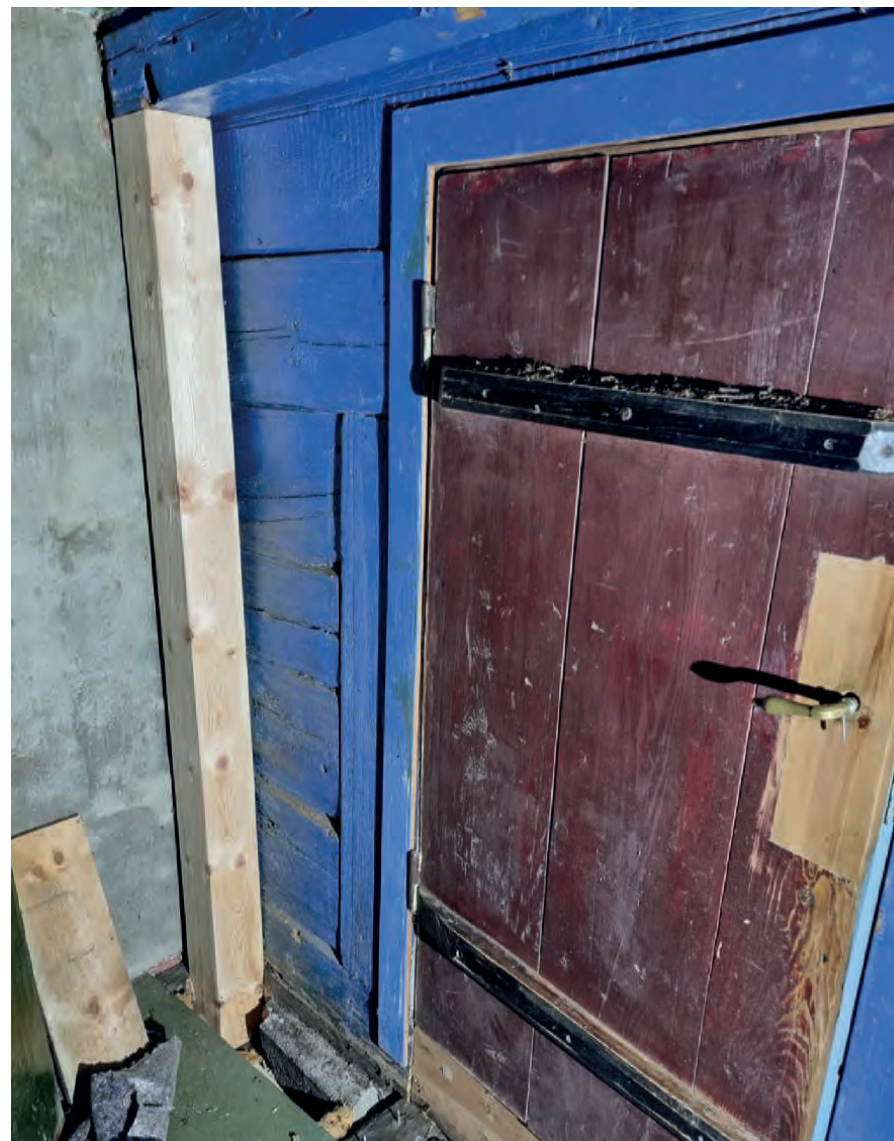
Ny bæring bak flatbrødskapet før den ble malt blå. Spunsing i dørblad består umalt.
