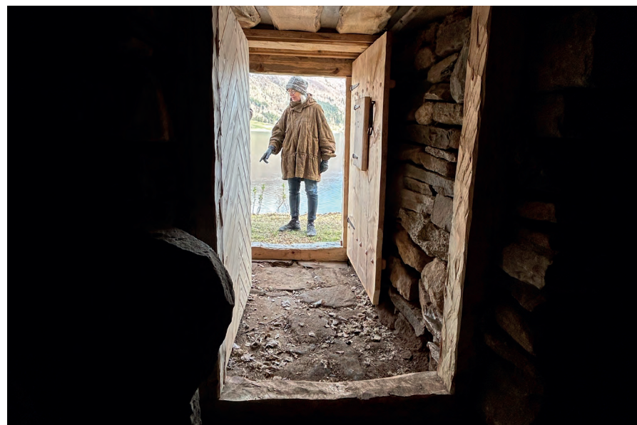
Den nye forgangen med to nye dører. Det gamle hellegulvet synlig. Befaring med Astrid Opsal, kulturminnefaglig rådgiver i prosjektet.
