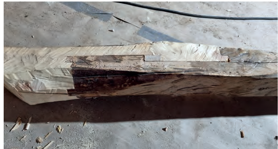
Reparasjon sperr. Sammenføyning nytt gammlet
