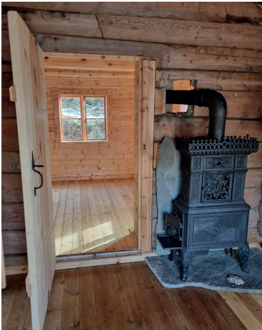
Veggene på den rekonstruerte bindingsverksdelen (bakre rom i bildet) ble isolert med trefiberisolasjon. Bjelkelaget er rekonstruert basert på funn på stedet. To originale bjelker er gjenbrukt. Gulvene i reisverksdelen ble isolert med trefiberisolasjon.
