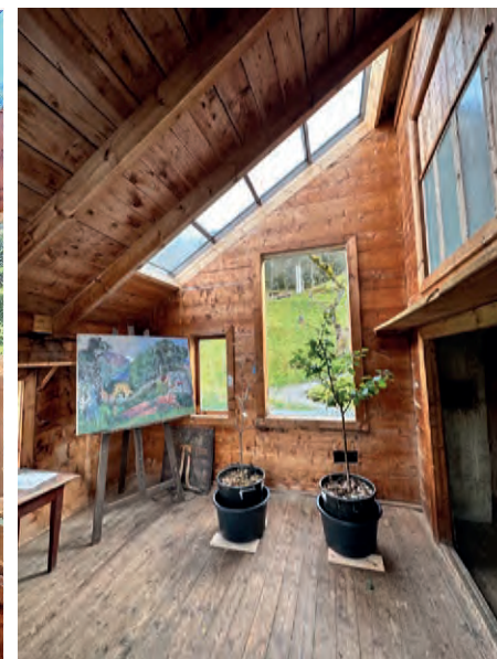
Rekonstruksjon av det overlyset i atelieret baserte seg på gode spor i bygget og på fotodokumentasjon.
