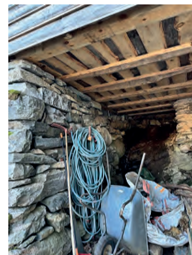
Dreneringen under bygget er utbedret.
