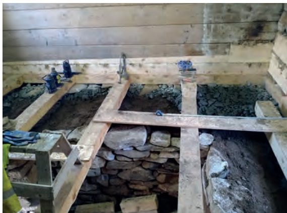
Nye sviller og bjelkelag. Legging av gulv, med mose i stubbloftet.
