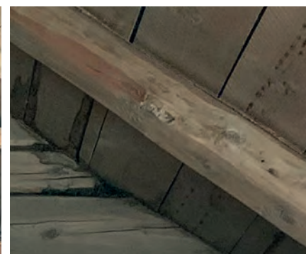
Det er spor av papp/ tapet på undersiden av taktroa i overgang til sperrene. Vi har ingen dokumentasjon på hva tid det var montert papp/ tapet her.
