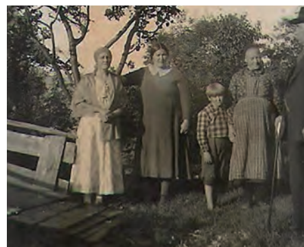
Foto fra tidlig på 1930-tallet viser rekkverket på broen utført i plank.
