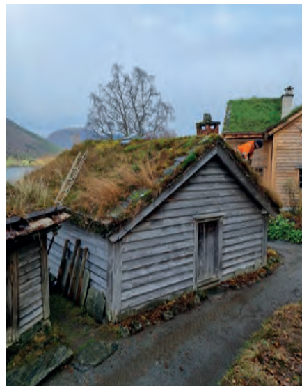
Taket ble lagt om. Pipen måtte demonteres for oppmuring av ny pipe
