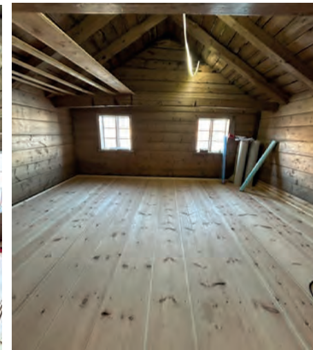
Gamlestova ferdig restaurert med nytt gulv.
