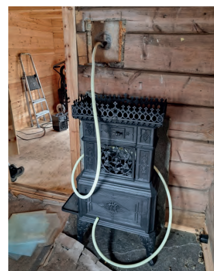
Pipen har innvendig plastforskaling hvor det går trekkerør til varmeelement i ovn.
